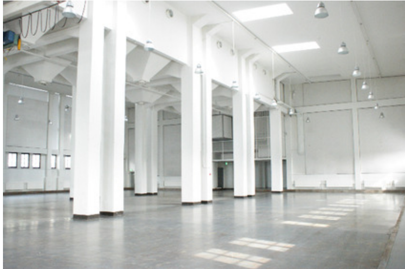
Kuva 13. Kuva Kattilahallisista sisältä (Suvilahti 2011).
