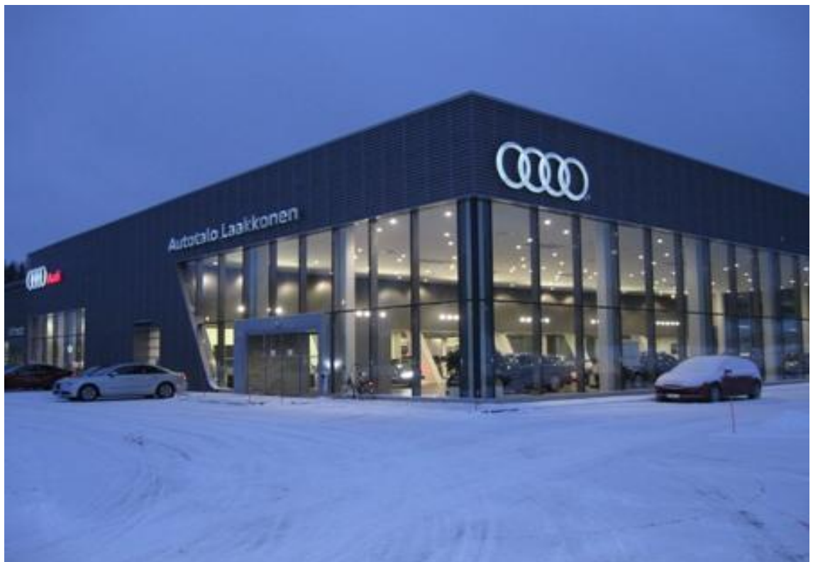
KUVA 8. Audin huollon vastaanottopisteen sekä automyymälän ulkoasu
