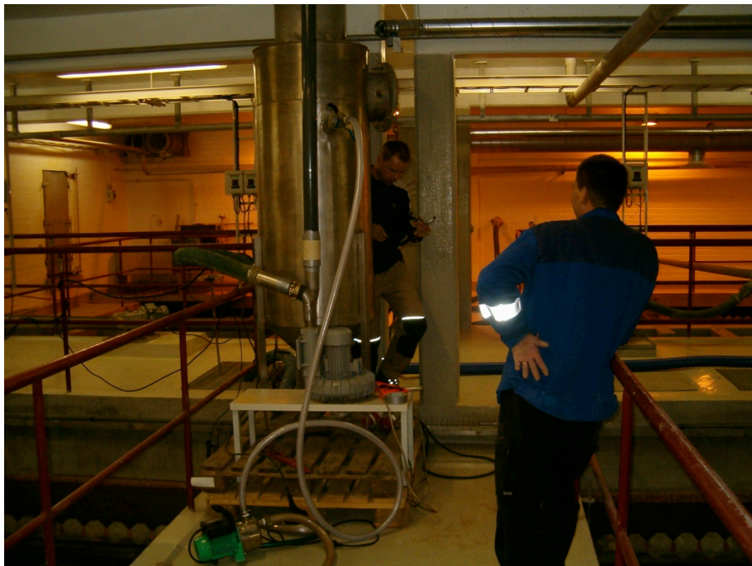
Kuva 11. Asennusvaihe 2. laitteisto valmiina koekäyttöön
