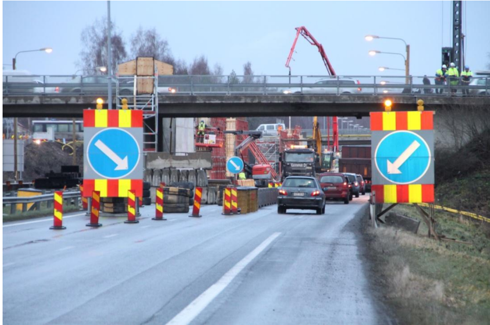
Kuva 17. Vasemman kaistan sulkukohta moottoritillä.
