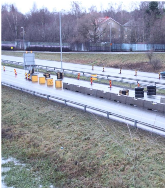
Kuva 18. Vasemman kaistan sulkukohdan suojaus.
