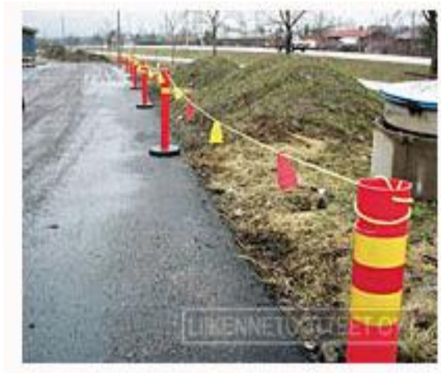
Kuva 4. Esimerkki sulkuköyden käytöstä (Liikennetuotteet Oy n.d).
