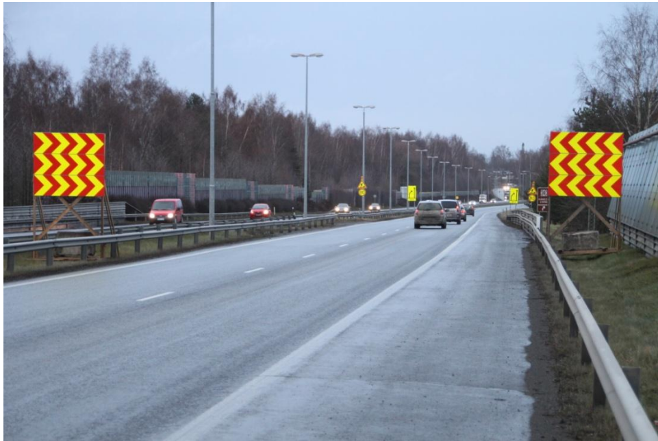
Kuva 15. Heräteaidat moottoritiellä.
