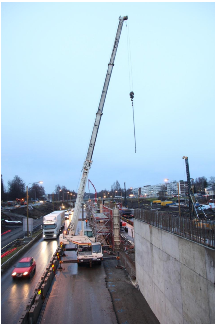
Kuva 13. Tilantarve keskikaistalla työskentelyssä.
