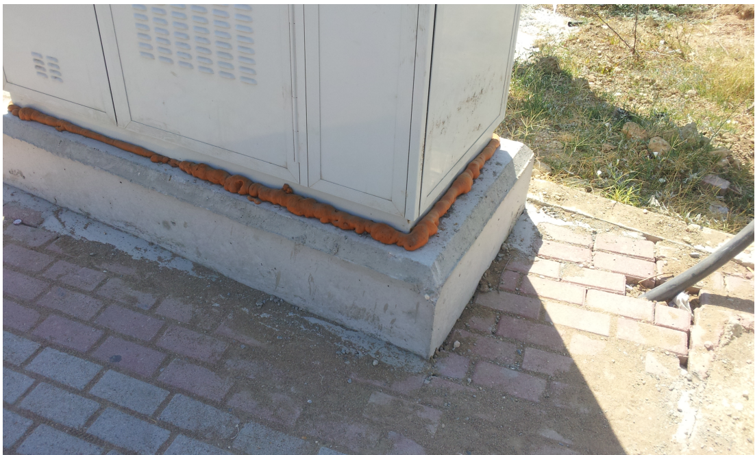
KUVA 2. Polyuretaania eristeenä turkkilaisen sähkökaapin ja perustuksen liitoksessa
