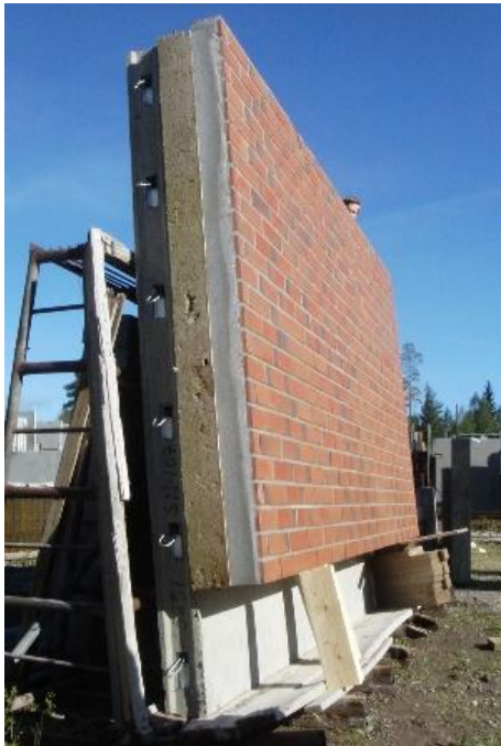
Kuva 9. Tiililaattapintainen sandwich-elementti (Rakennusperintö 2012.)
