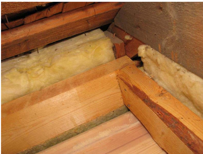
KUVA 8. Uudisosan seinä- ja yläpohjarakenteet. Kuva Joonas Vauhkonen
