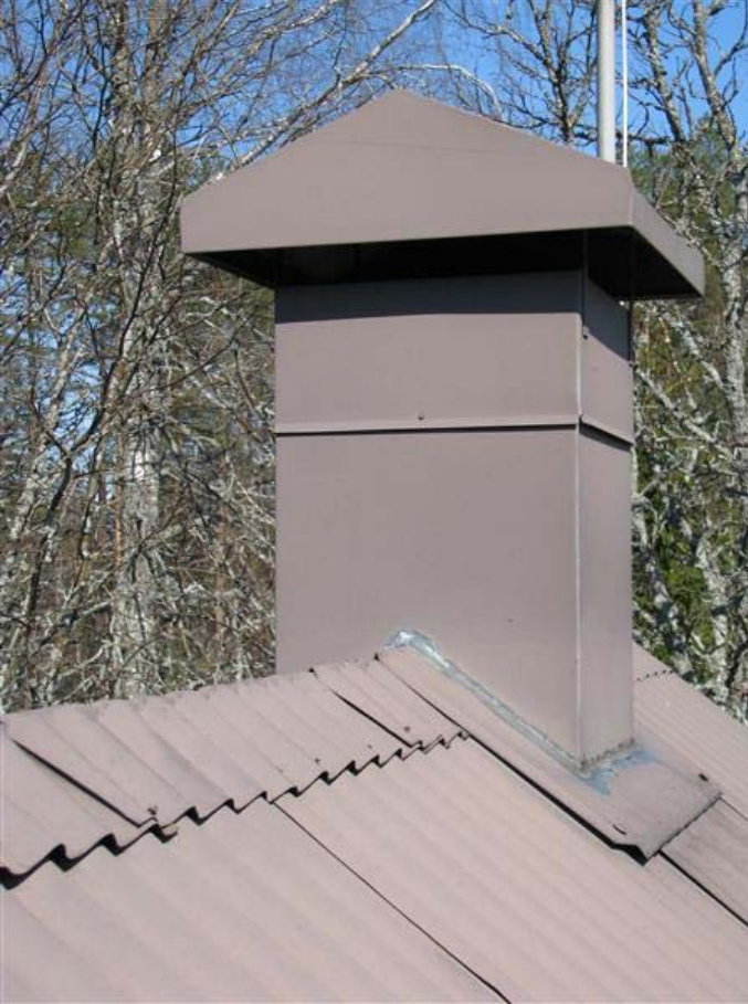
KUVA 13. Ilmanvaihtokanavan hattu. Kuva Joon Vauhkonen
