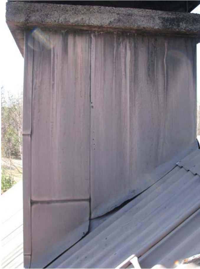
KUVA 15. Hormi. Hormin suojapelti ja läpivienti on säilyttänyt vedenpitävyytensä.
