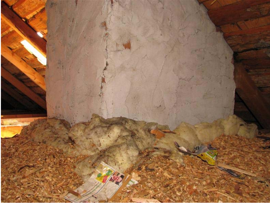
KUVA 11. Hormi yläpohjassa. Paloeristeenä on pehmeä mineraalivilla. Kuva Joonas Vauhkonen
