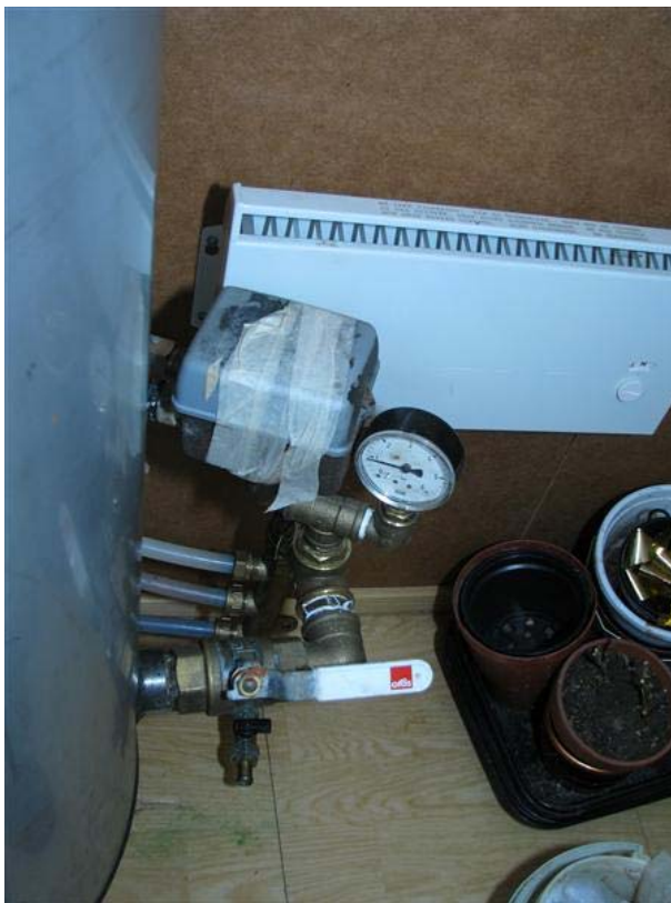
KUVA 18. Paisuntasäiliö ja venttiili. Kuva Joon Vauhkonen
