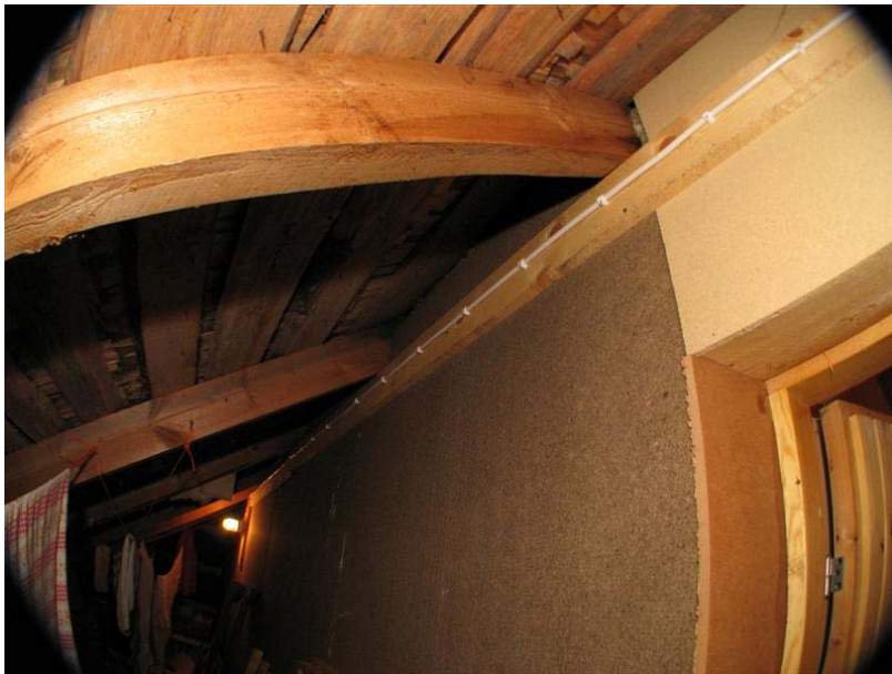
KUVA 7. Kattoruoteet ja seinä (US2). Kuva Joonas Vauhkonen
