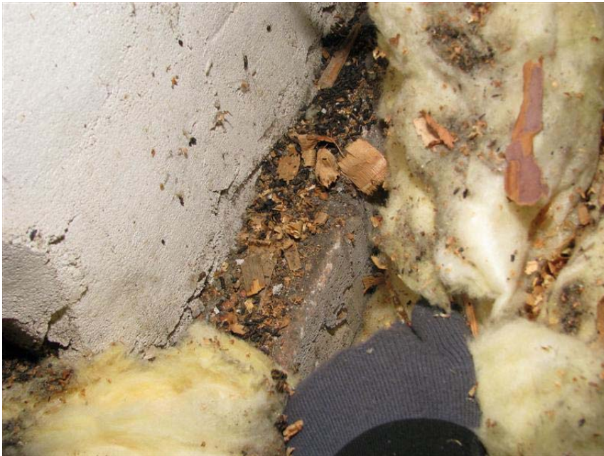
KUVA 12. Hormi yläpohjassa. Yläpohjan läpiviennin kohdalla hormissa on levike parantamassa paloturvallisuutta. Kuva Joonas Vauhkonen
