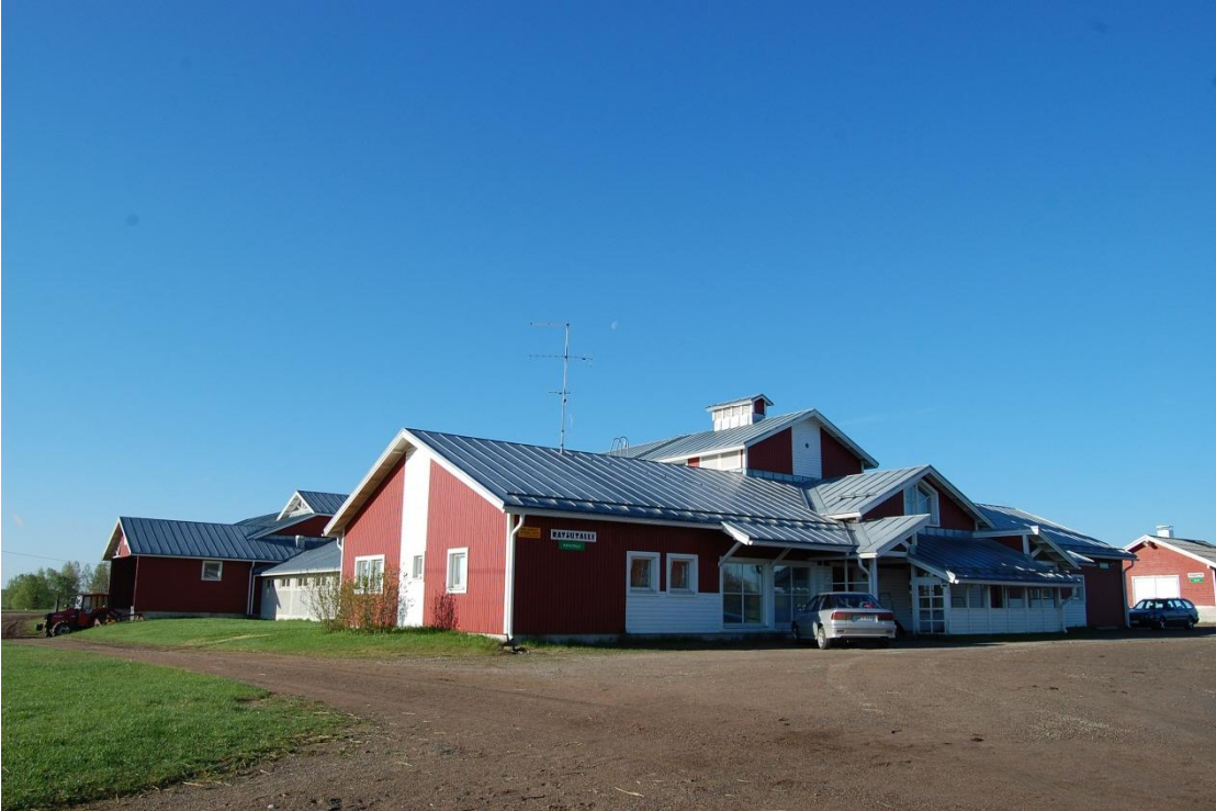
KUVA 8. Hevosalan oppilaitokset ovat toimivat omalta osaltaan työllistäjinä. Hingunniemen ratsutalli. Valokuva Elina Kyrönviita 2011
