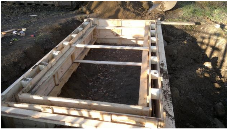
KUVA 12. Valmiit muotit betonivalulle.
