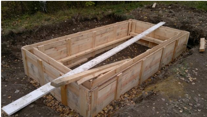
KUVA 11. Keskeneräinen muotti betonivalulle.
