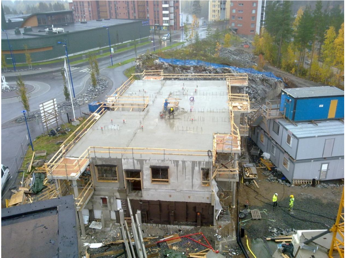
Kuva 2. Käynnissä oleva 2 kerroksen holvin valu. Kuva Lauri Alanko.
