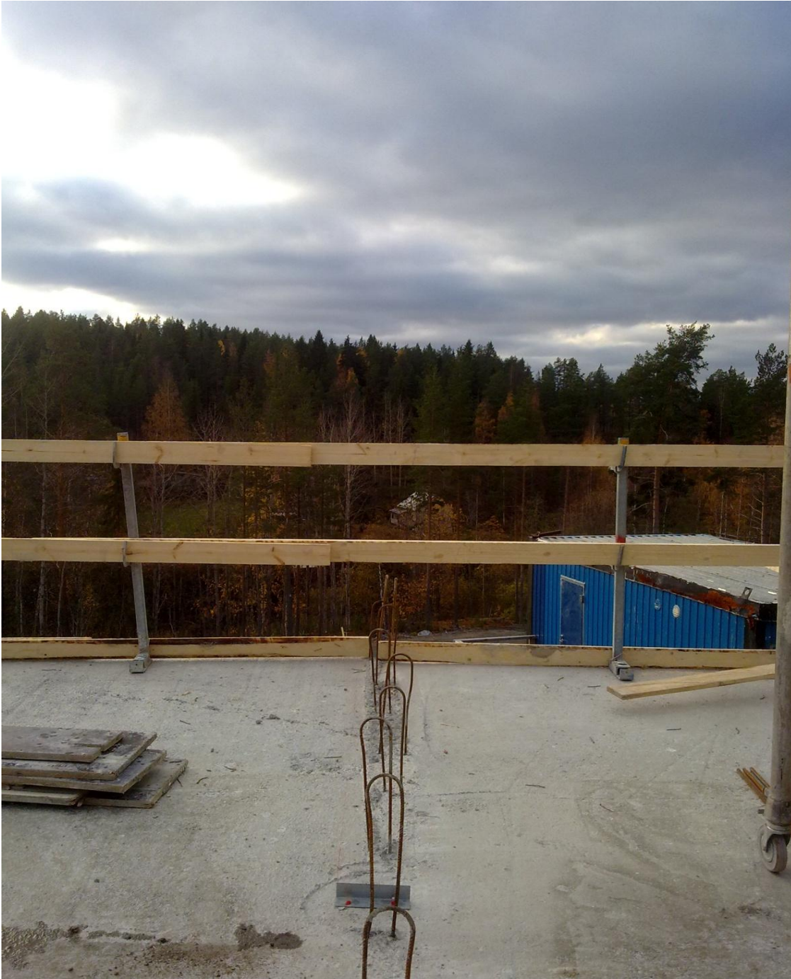
Kuva 14. Porattavat kaiteet asennettu siten, ettei niitä tarvitse irrottaa seinämuottien asennuksen ajaksi, näin reunus pysyy koko ajan suojattuna. Kuva Lauri Alanko.
