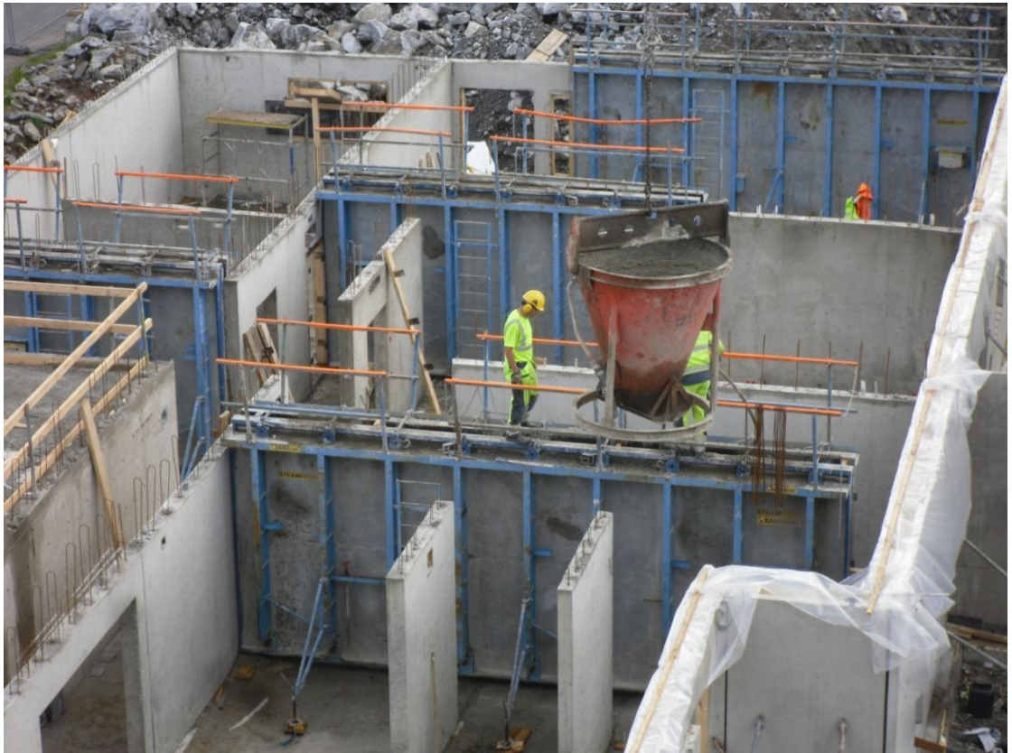
Kuva 4. Käynnissä Keilankaaren 1. kerroksen seinän valu, vahvuus 2 RAM, valu suoritetaan käyttämällä nostoastiaa. Kuva Lauri Alanko.
