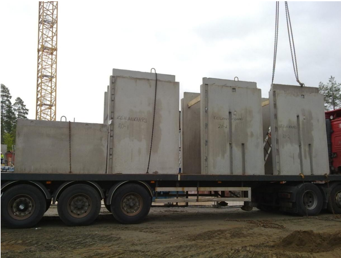
Kuva 7. Ensimmäisten Keilankaaren elementtien purku. Hissikuiluelementit voidaan varastoida työmaalla sisäkkäin, jolloin ne eivät vie paljoa tilaa. Kuva Lauri Alanko.
