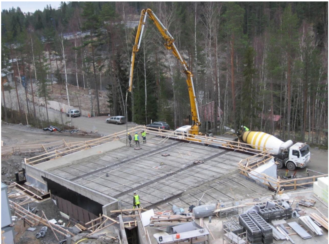
Kuva 3. Pumpulla tehtävä Keilankaaren autohallin pintavalu. Kuva Lauri Alanko.
