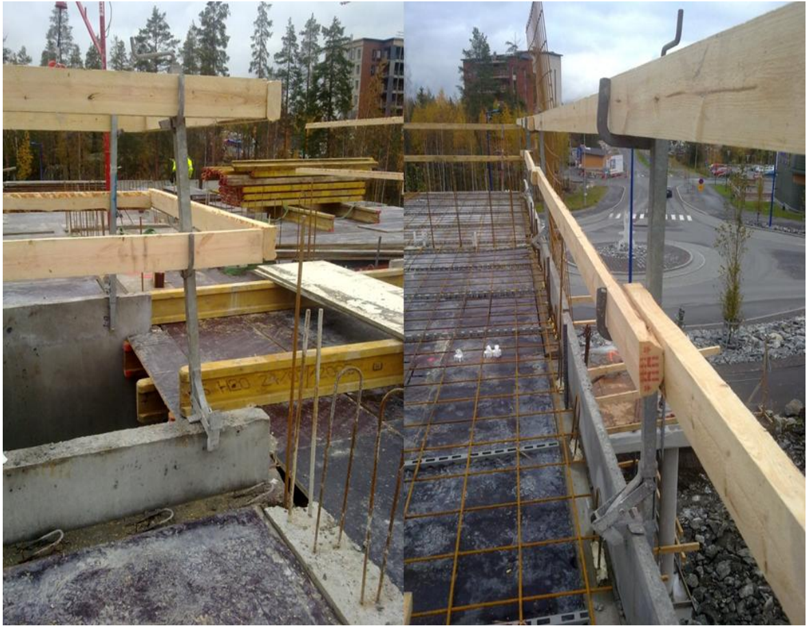
Kuva 13. Villanvälikäidetolppa kiinnitetty hissikuilussa sekä päätyelementissä. Kaiteet ovat siirrettäviä, joten raskaita kaide elementtejä ei tarvita. Samalla niillä voidaan tehdä turvallinen reunus, mikäli esim. suurmuotit ylittävät holvin reunan. Kuva Lauri Alanko.
