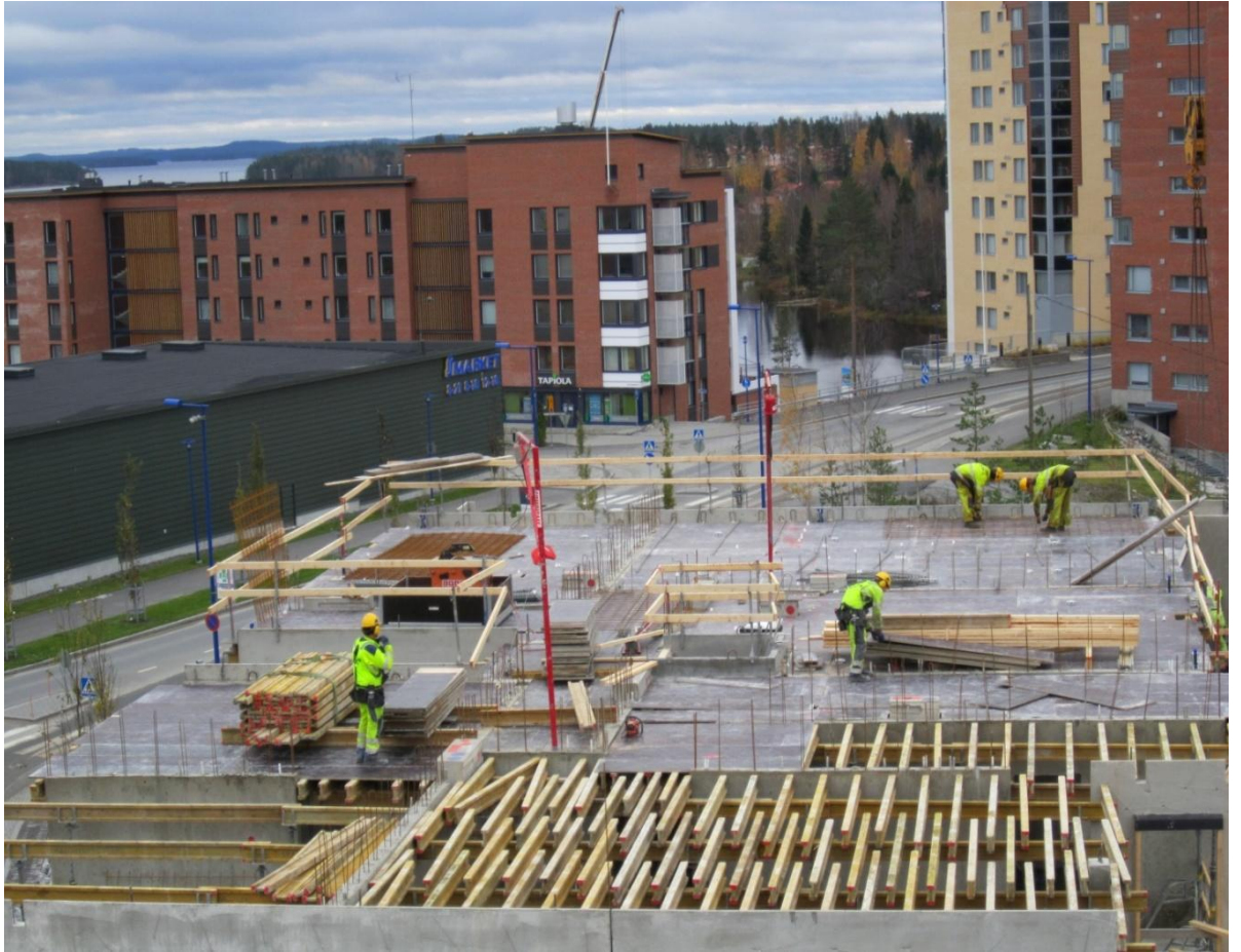
Kuva 11. Hirsipuut käytössä kolmannen kerroksen holvimuotin teossa. Hirsipuut tuovat vaijerikeloineen turvallisen työskentely-ympäristön, jolloin muotin reunalla tehtävä kaide on helppo asentaa. Kuva Lauri Alanko.
