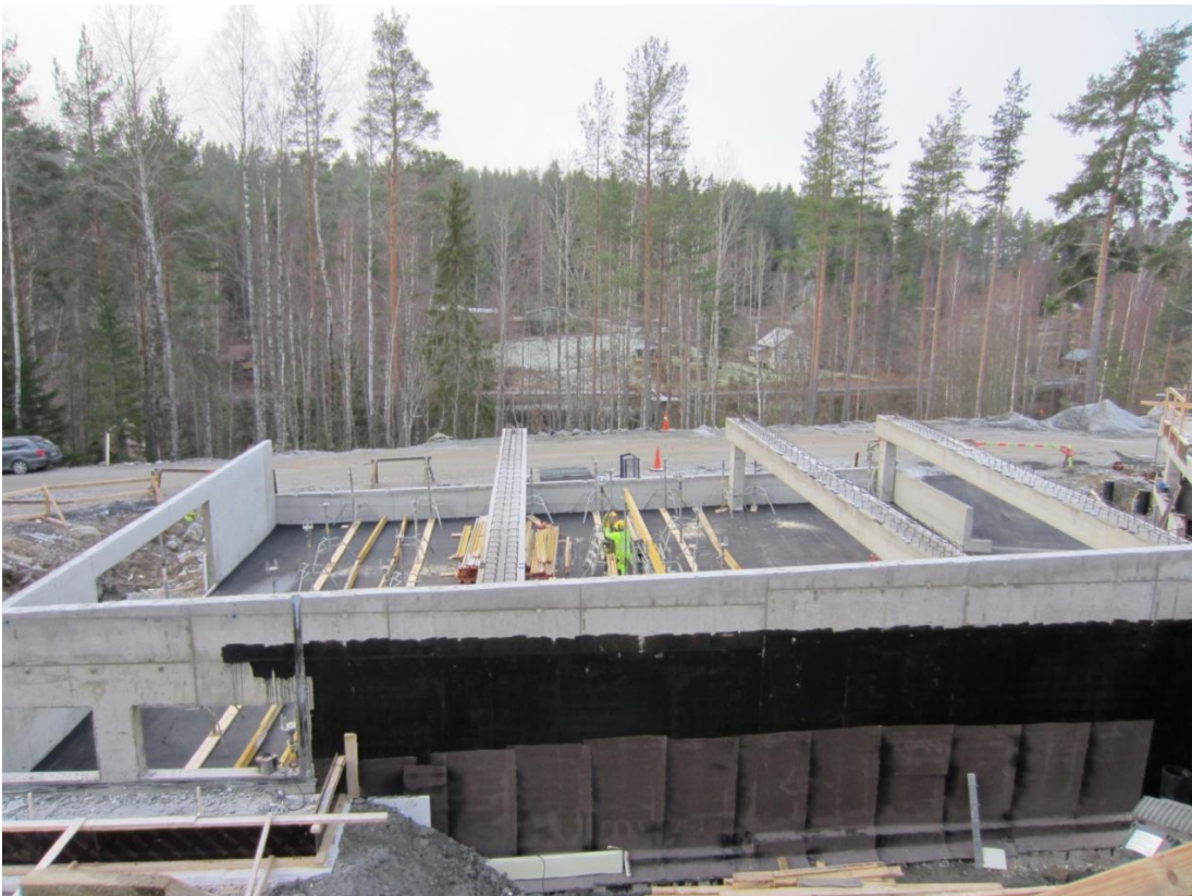
Kuva 6. Keilankaaren autohalliin asennetut JK- palkit. Kuva Lauri Alanko.
