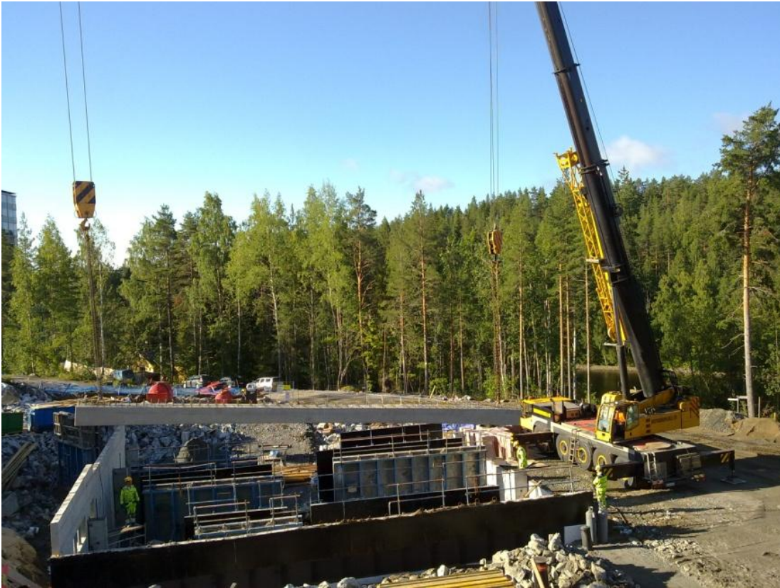
Kuva 5. Palkin asennus Laivakaaren osaan autohallista, nosto vaatii ajoneuvonosturin avuksi, palkin paino ~21t. Kuva Lauri Alanko.
