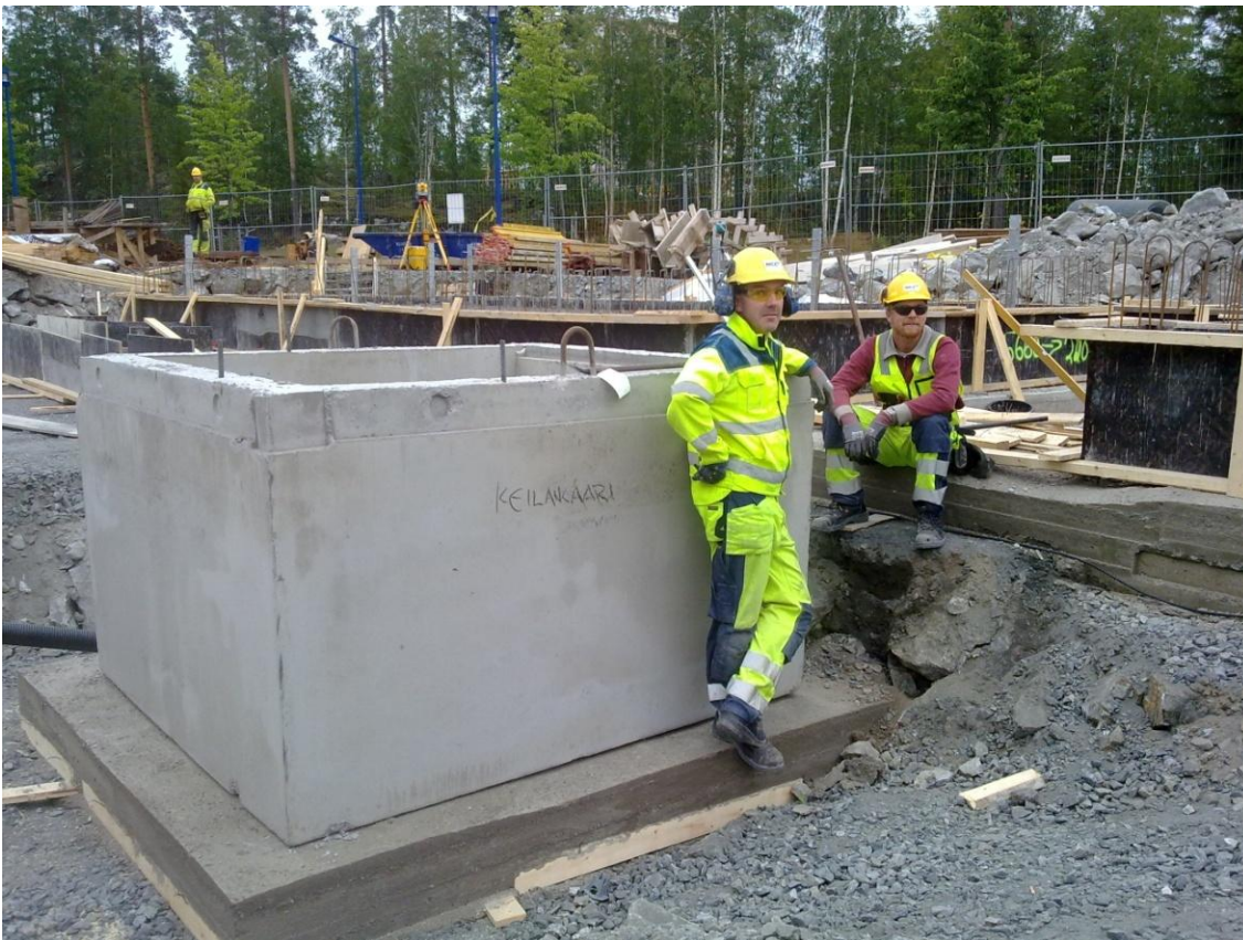
Kuva 9. Ensimmäinen Keilankaareen asennettu elementti, HA-1. Kuva Lauri Alanko.
