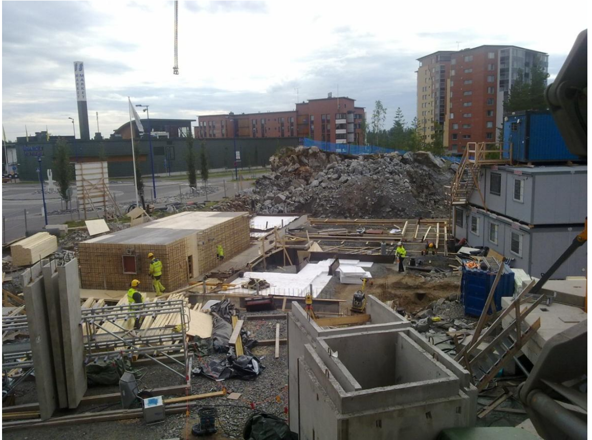
Kuva 8. Pielielementtien varastointi fakkiin sekä hissikuluelementtien varastointi limit-täin. Taustalla väestönsuojan muuttityöt. Kuva Lauri Alanko.
