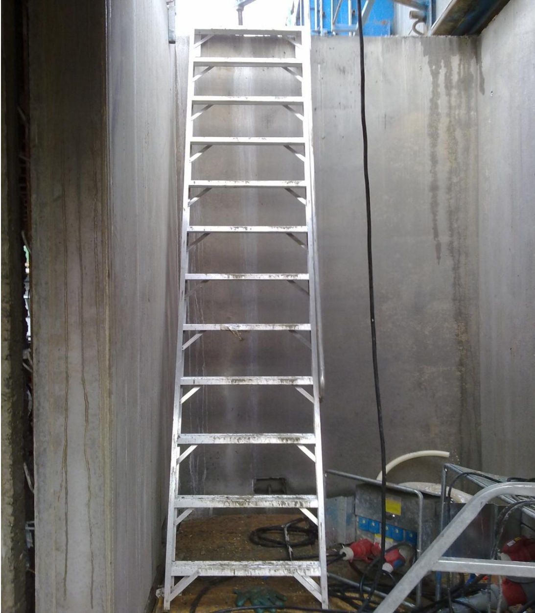
Kuva 12. Hissikuiluun suunnitellut holvitikkaat, joissa on kaide mukana. Kätevät siirrellä käsin, joten nosturia ei erikseen tarvita. Kuva Lauri Alanko.
