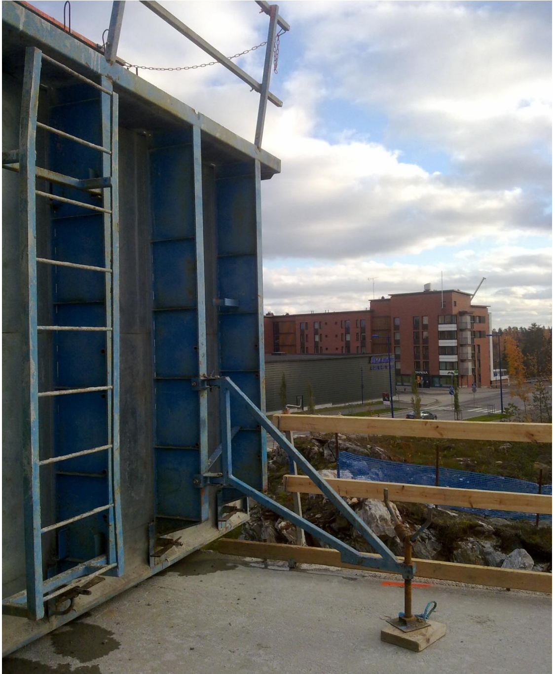
Kuva 15. Villanvälikaide on asennettu elementtiin siten, ettei sitä ole tarvinnut ottaa pois muotin tieltä vaan suojaus on voitu pitää paikoillaan. Kuva Lauri Alanko.
