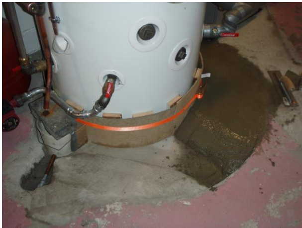
KUVA 23. Lattiassa varaajan viereen jäänyt aukko täytyi valaa umpeen
