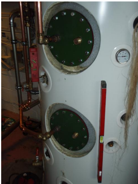
KUVA 18. Osa putkitöistä tehtynä ja liitettynä lämminvesivaraajaan
