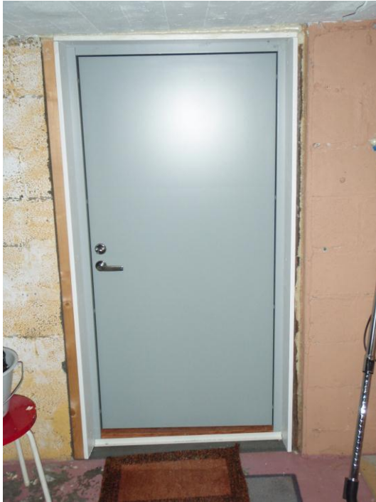
KUVA 22. Uusi, tiiviimpi ja hyvin lämpöä eristävä ovi asennettuna
