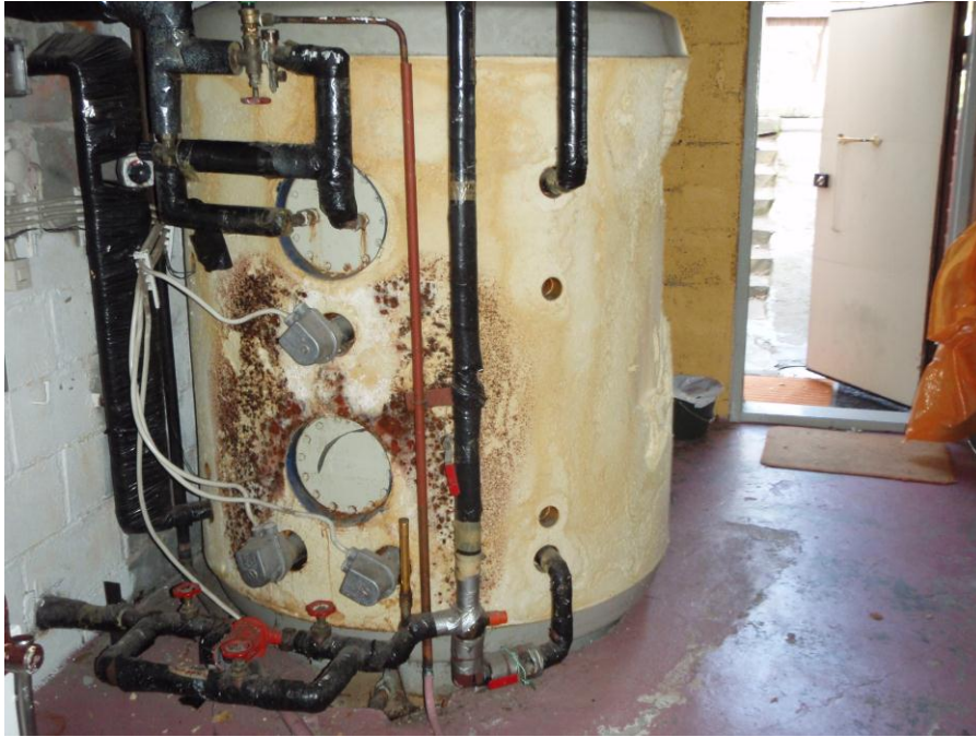
KUVA 7. Lämmityksen taloudellisuuden vuoksi vanha lämminvesivaraaja vaihdettiin uuteen
