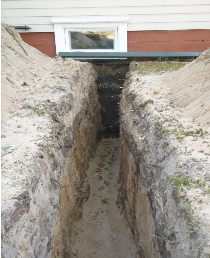
KUVA 6. Maata jouduttiin kaivamaan yli kahden metrin syvyyteen
