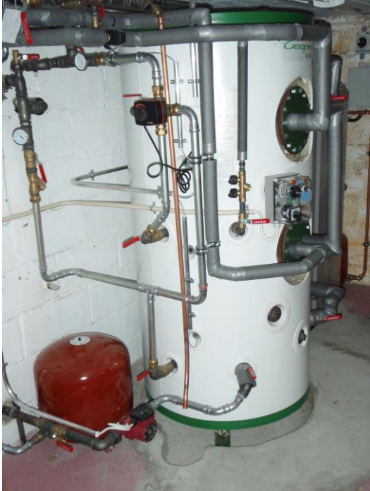
KUVA 24. Putkityöt, pumppu ja varaaja asennettuna ja valmiina toimimaan
