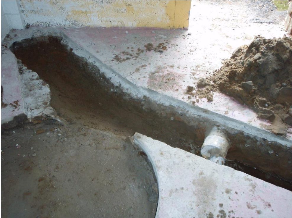
KUVA 11. Lattialaatta piikattuna ja ura valmiina putkien asennusta varten
