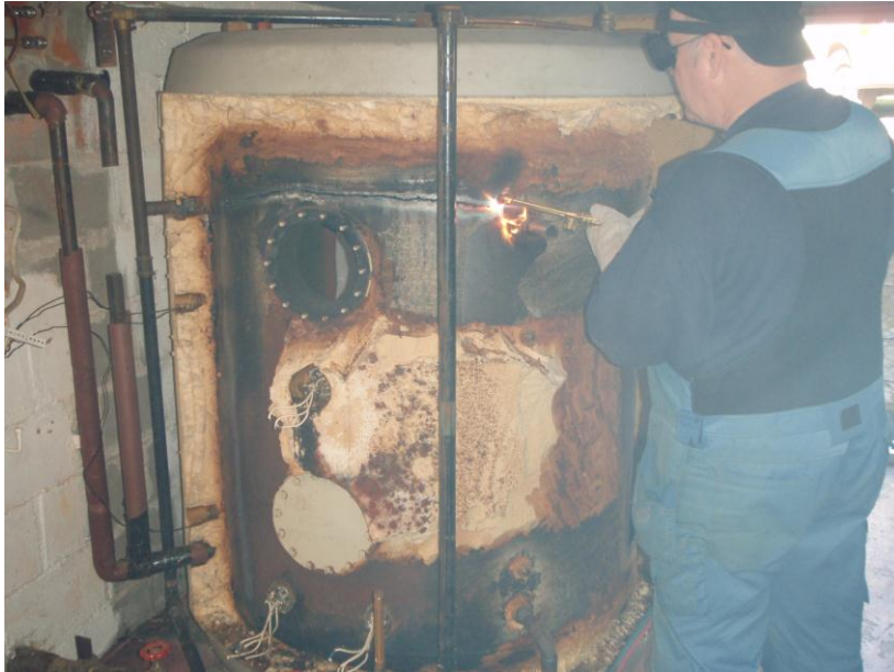
KUVA 8. Varaajan polttoleikkaus osiin
