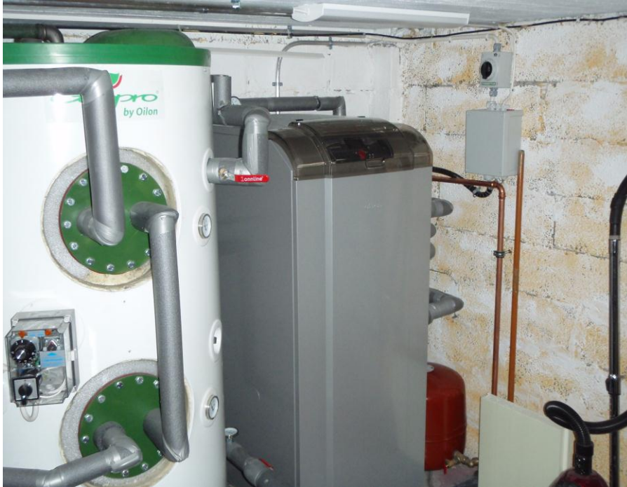
KUVA 27. Lämpöpumpun käyttöönotossa ei ollut ongelmia
