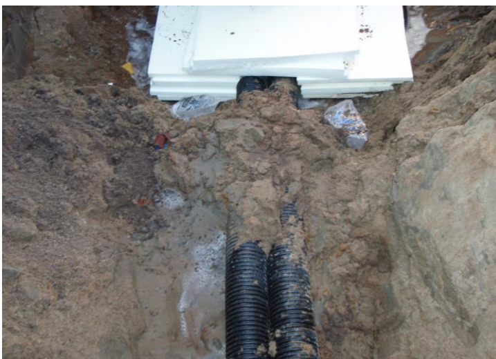
KUVA 15. Lämpökaivon yläosassa lämmönkeruupiirin putket liitettiin toisiinsa ja liitos suojattiin
