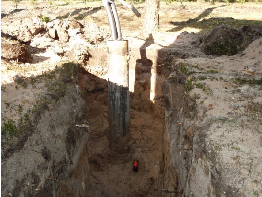
KUVA 5. Porakaivon pintaosa ja aloitetut kaivuutyöt
