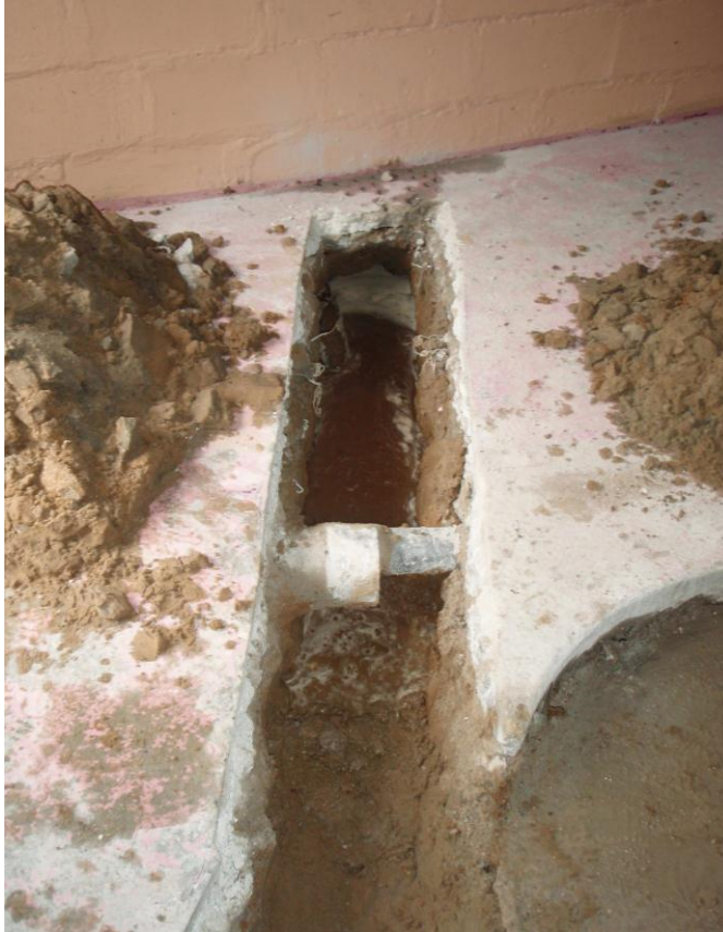
KUVA 10. Lattialaattaa piikatessa täytyi varoa putkia
