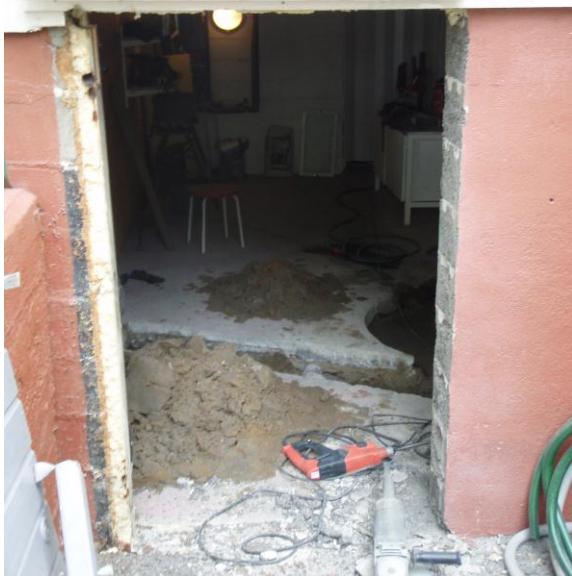
KUVA 12. Oviaukkoa levennettiin sopivaksi uutta leveämpää ovea varten
