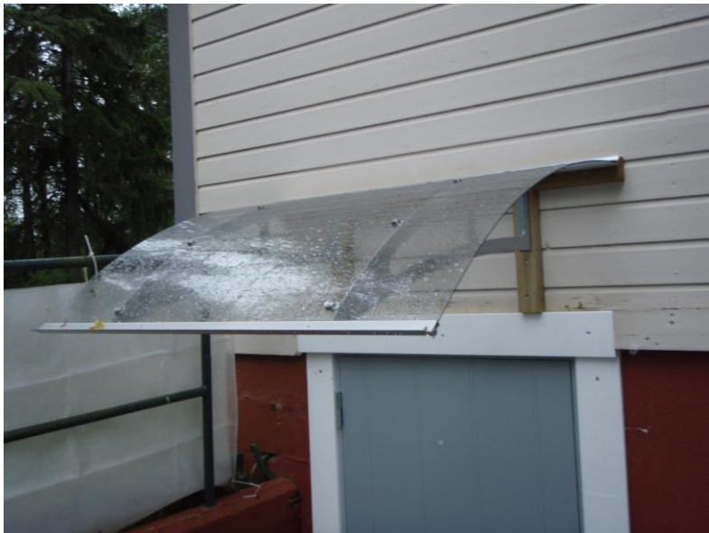
KUVA 26. Ulos, oven päälle asennettiin katos suojaamaan ovea vedeltä
