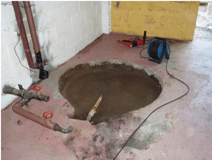
KUVA 9. Uusi varaaja suunniteltiin asennettavaksi vanhan varaajan jättämään aukkoon
