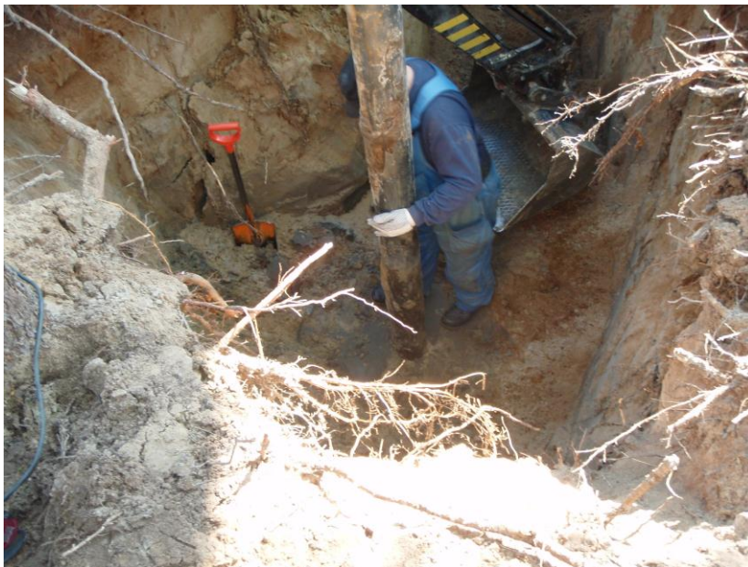
KUVA 13. Ilman kaivurin apua näitä kaivantoja ei olisi saatu tehtyä ajoissa
