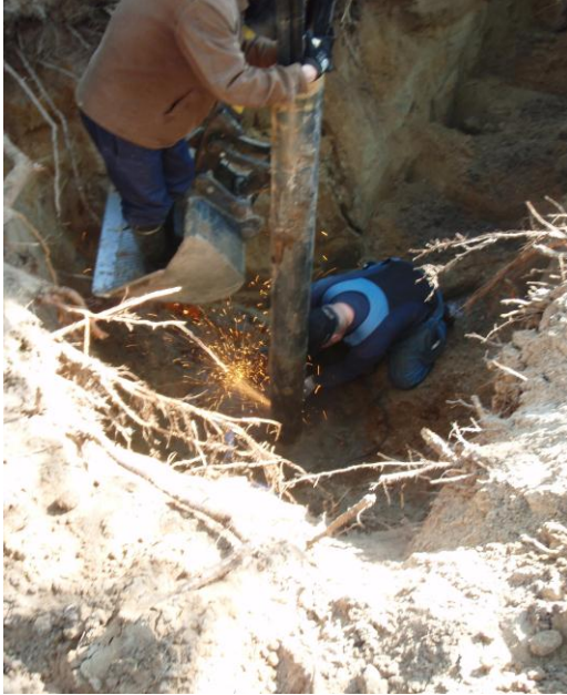
KUVA 14. Töitä vaikeutti huomattavasti kaivannon syvyys
