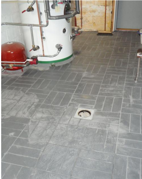
KUVA 25. Huoneen lattiasta tehtiin vedenkestävä ja tasainen
