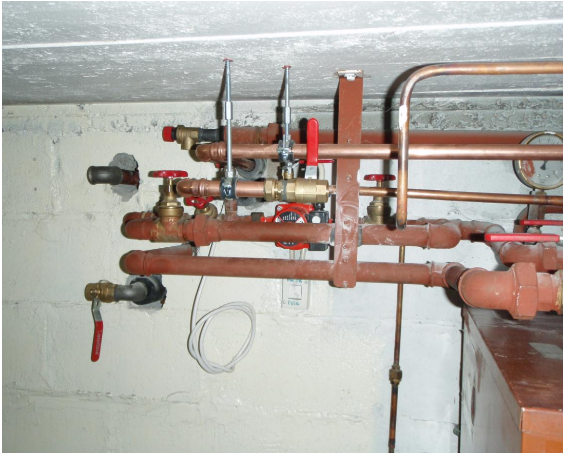
KUVA 19. Valmiit lähtövesiputket talon toista puolta varten
