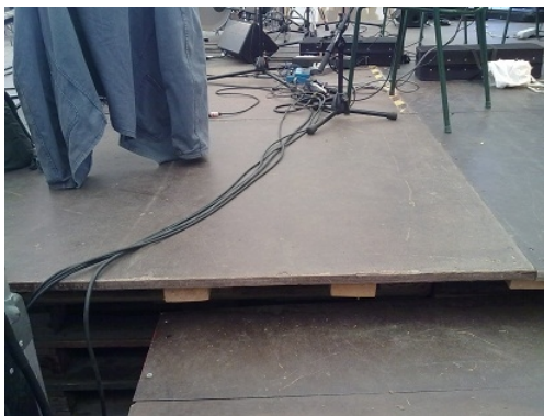
Kuva 41. Johtojen vetäminen siististi samaa linjaa pitkin (Kuva: Mia Heinonen)
