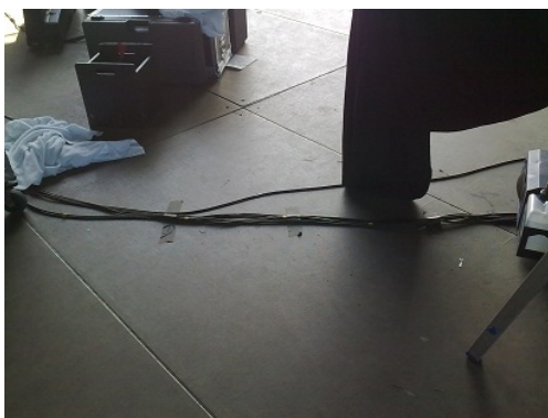
Kuva 42. Johdot siistissä linjassa teipattuna (Kuva: Mia Heinonen)
