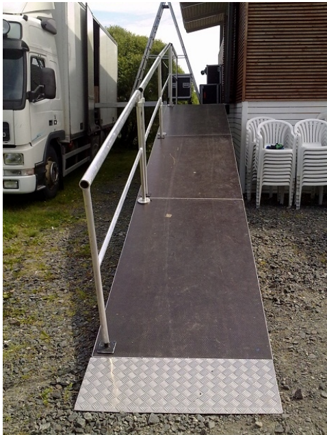
Kuva 35. Paloista rakennettu ramppi ulkolavan takaosassa (Kuva: Mia Heinonen)
