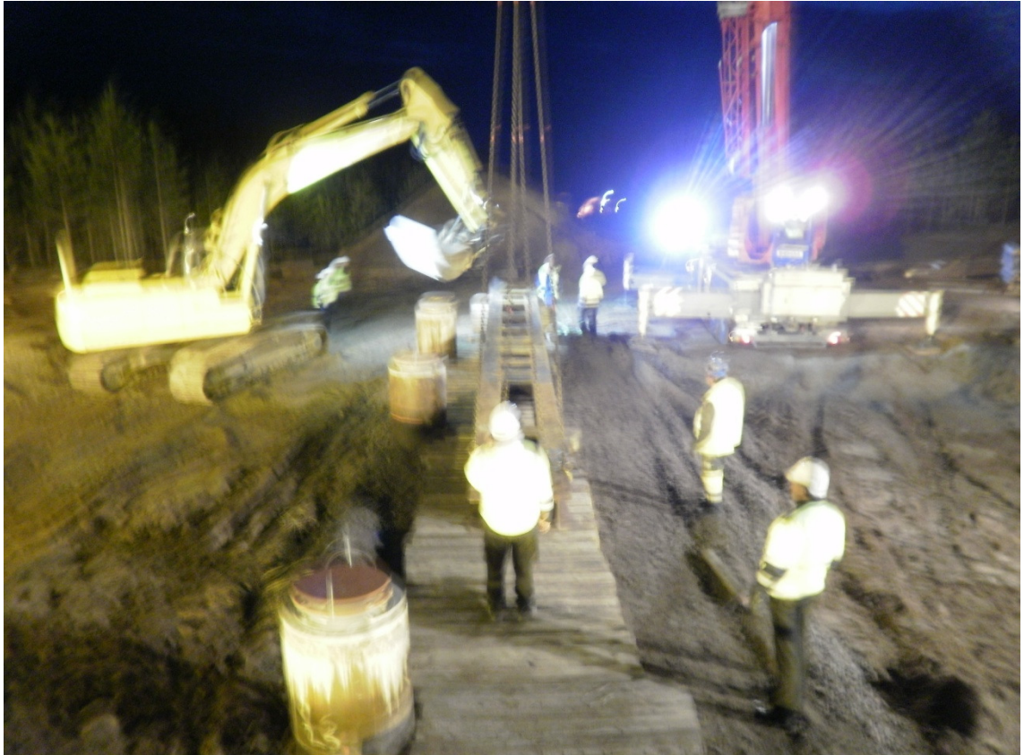
Kuva 10. Siirtoradan pelkoitus valmiina ja siirtokiskon alle tulevan palkkien asennus. (Destia Oy)
