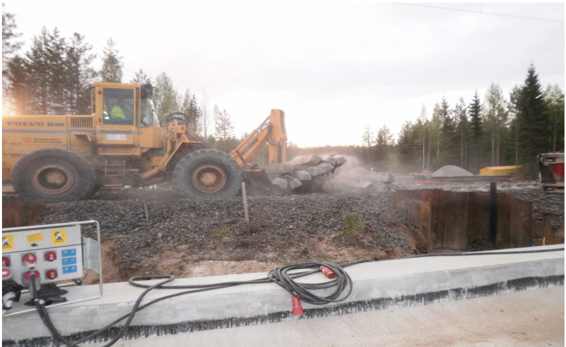
Kuva 8. Kiskojen alla olevien ratapölkkyjen poisto. (Destia Oy)
