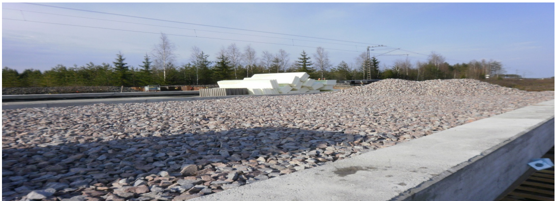
Kuva 13. Raidesepeli valmiina. (Destia Oy)
