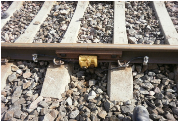
Kuva 6. Kiskot katkaistu ja liitetty väliaikaisliitoksella. (Destia Oy)
