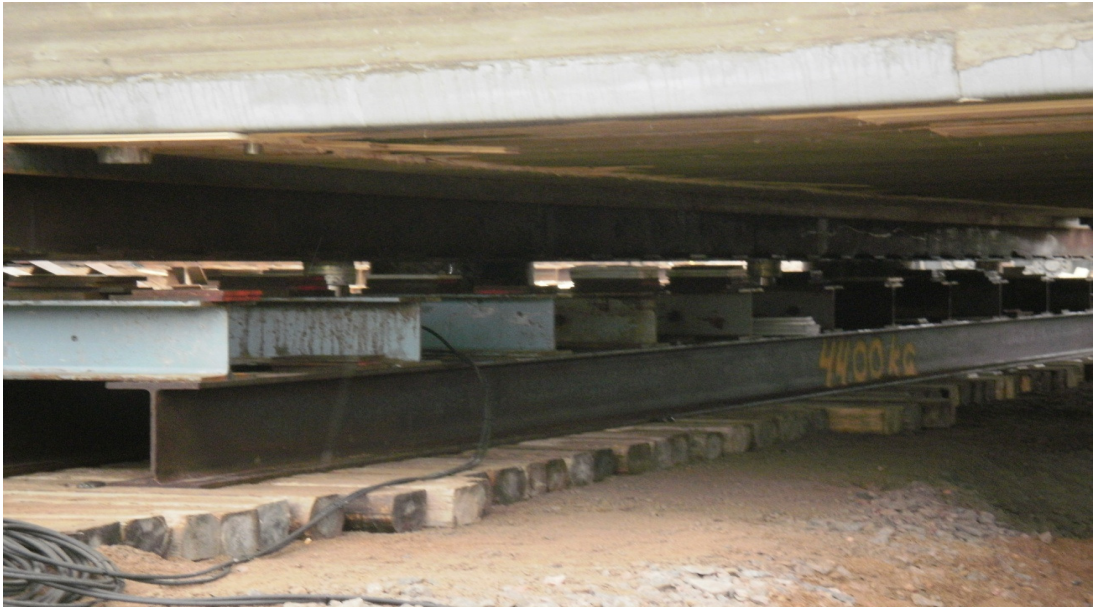
Kuva 11. Sillan paikalleen laskuun tarvittavat nostotunkit ja siirtokiskojen rakenne valmiina. (Destia Oy)
