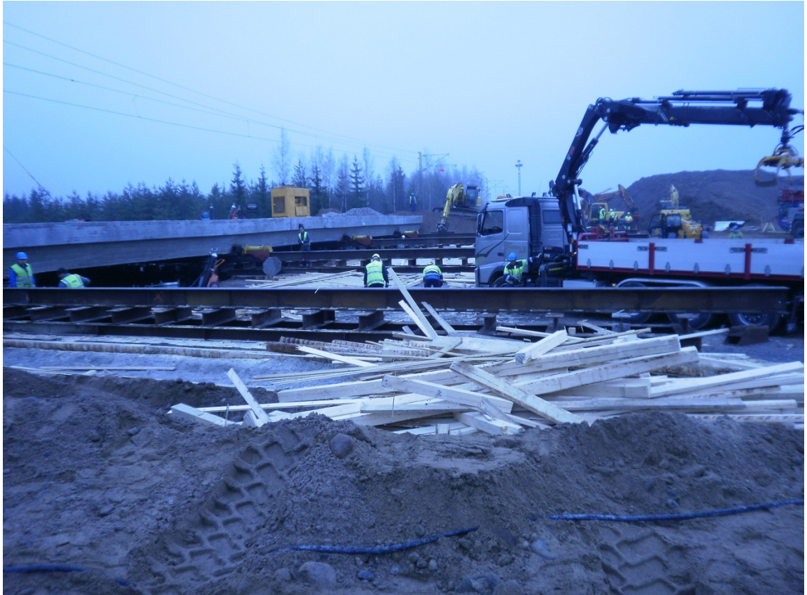
Kuva 4. Valmiiksi siirretty silta. (Destia Oy)
