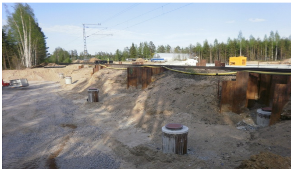
Kuva 7. Kuvassa näkyy kaapeleiden suojaus. (Destia Oy)
