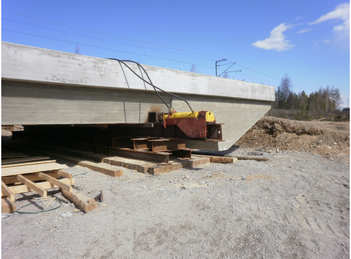
Kuva 3. Työntötunkit valmiiksi asennettuina. (Destia Oy)
