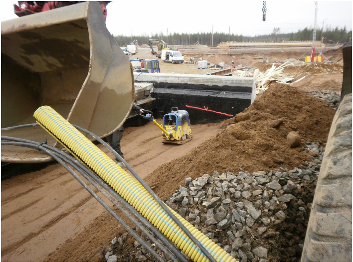
Kuva 5. Sillan päädyn täyttö ja tiivistys. (Destia Oy)
