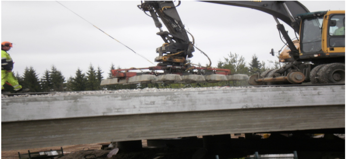
Kuva 14. Raidepölkkyjen asennus. (Destia Oy)
