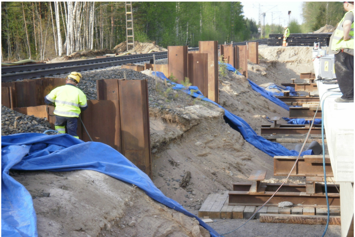
Kuva 2. Silta rakennettu radan viereen. (Destia Oy)
