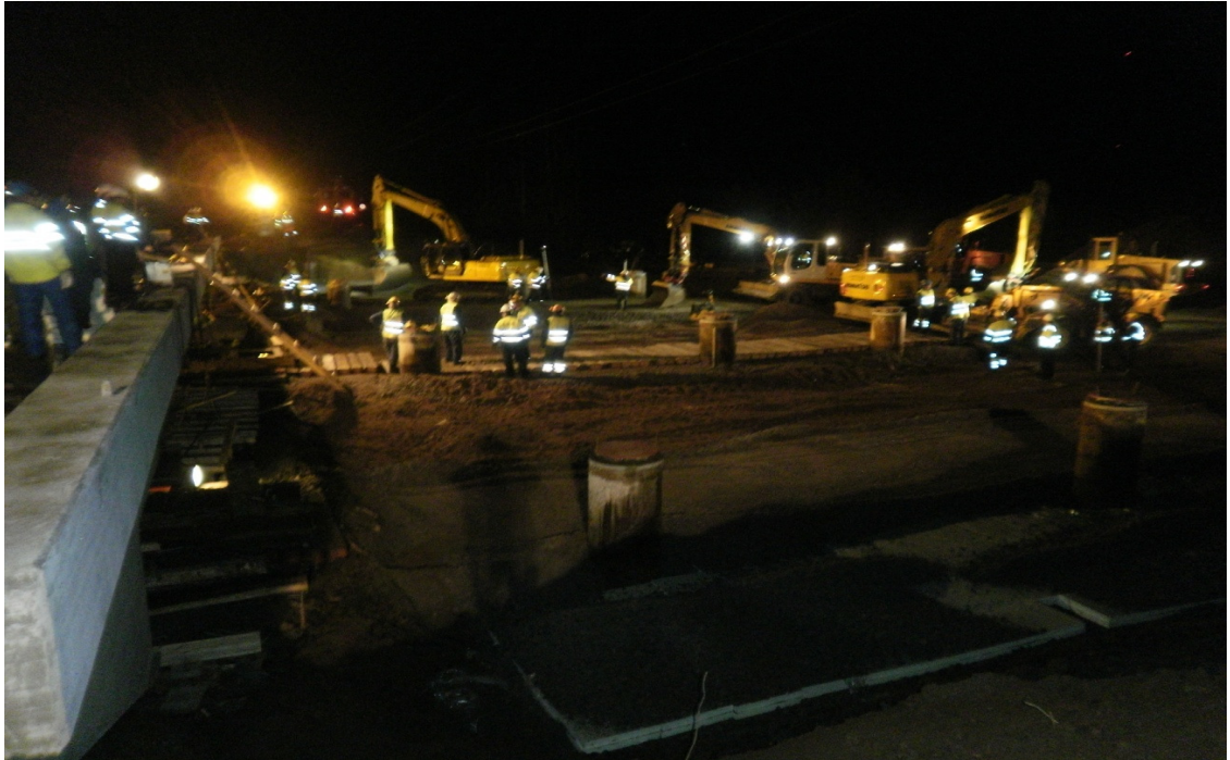
Kuva 9. Siirtoratojen pohjien teko ja sillanpäädyn routaeristys. (Destia Oy)
