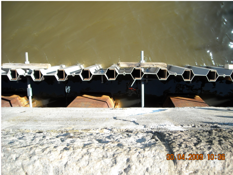
Kuva 32 Valmis muoviponttaus (Helsingin satama 2012.)
