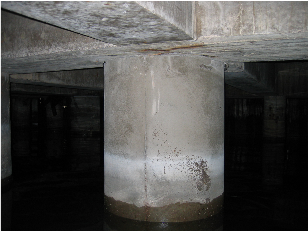
Kuva 29 Valmis, mantteloitu betonipaalu (Helsingin satama 2012.)
