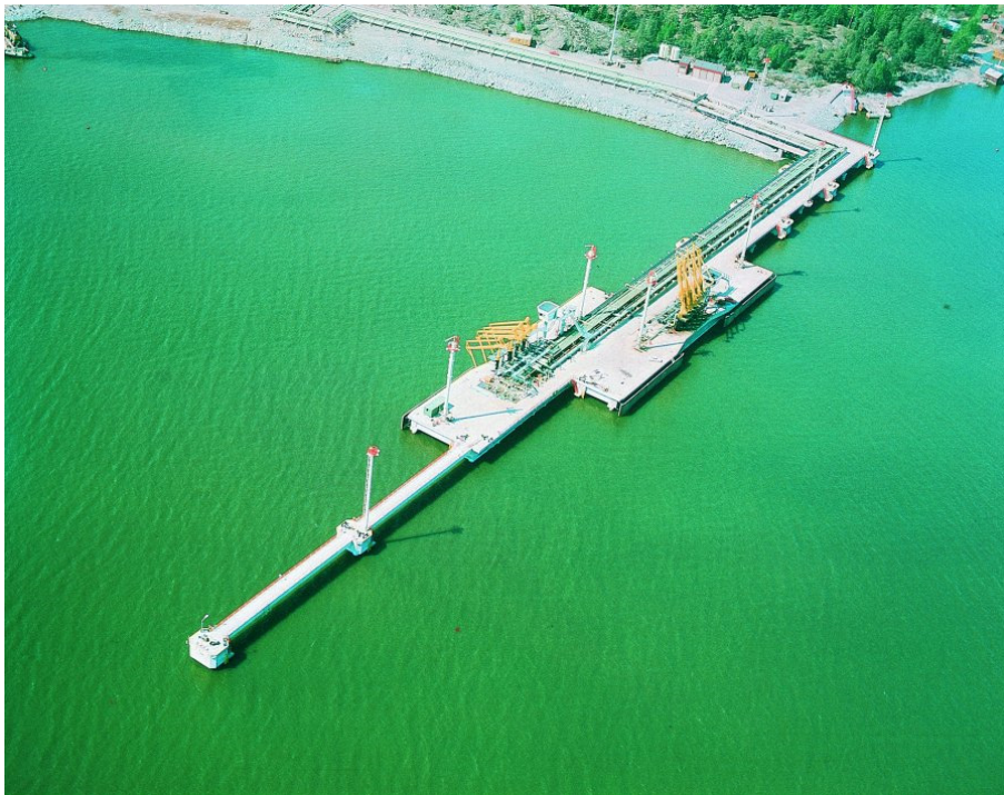
Kuva 3 Porvoon Kilpilahden öljysataman pistolaituri 2/3 (Pitkälä 2012.)
