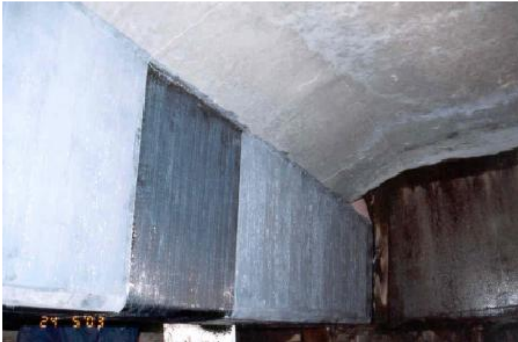
Kuva 30 Rakenteen hiilikuituvahvistusta (GT-Corporation 2012.)
