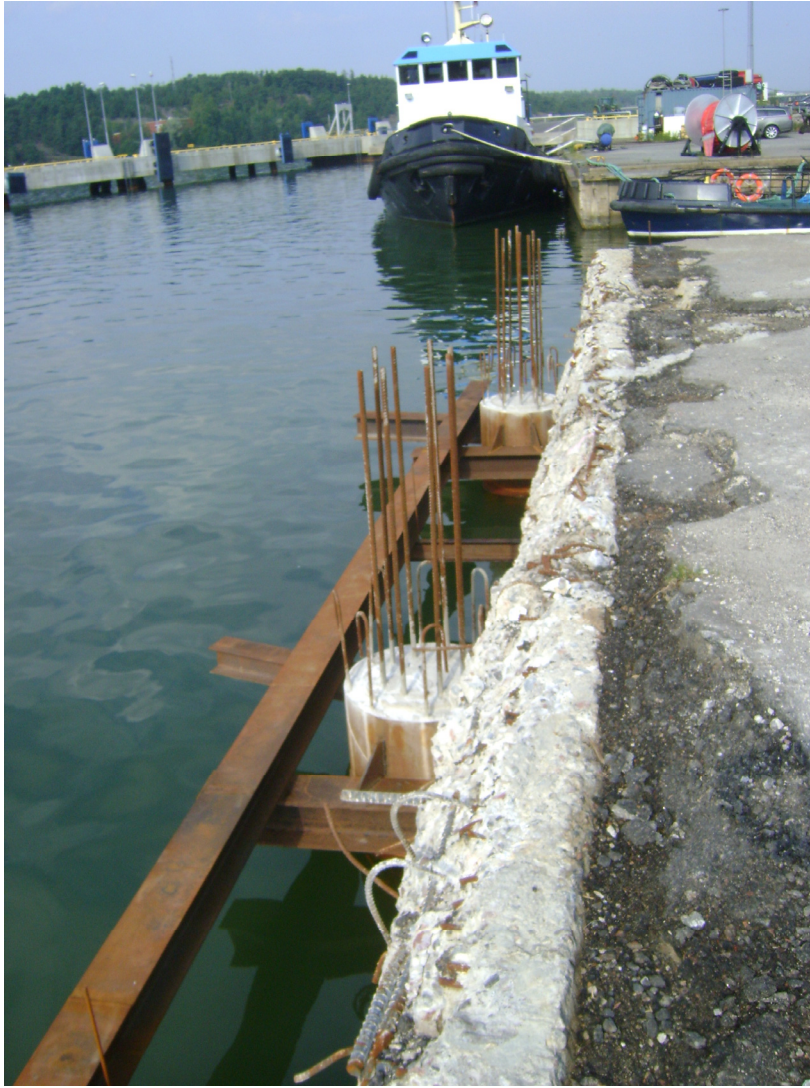
Kuva 36 Uutta paaluriiviä tehdään vanhan rakenteen viereen (Maasilta 2011.)
