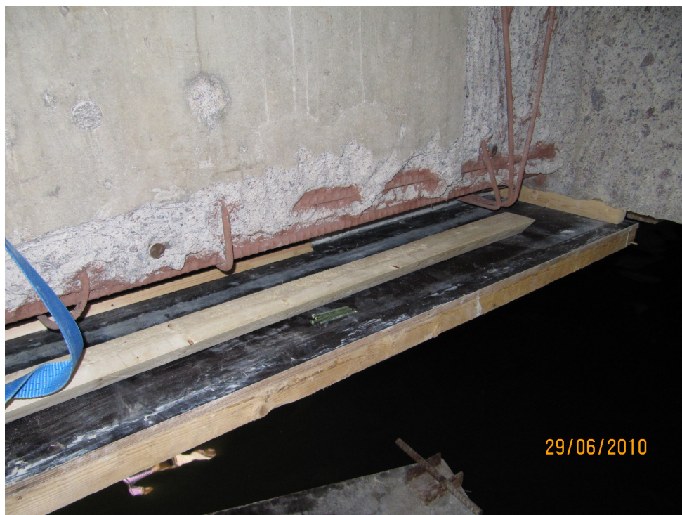
Kuva 26 Muotit valmiina valua varten vedenpinnan yläpuolisessa rakenteessa (Helsingin satama 2012.)
