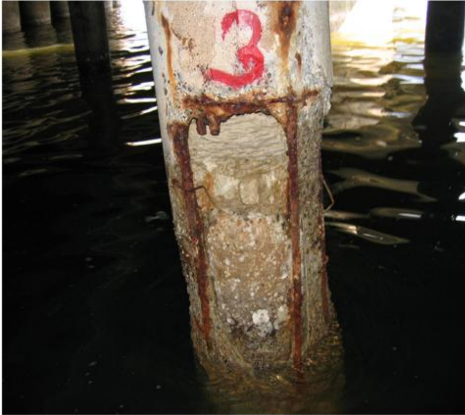
Kuva 28 Korjattava betonipaalu ennen manttelointia (Helsingin satama 2012.)
