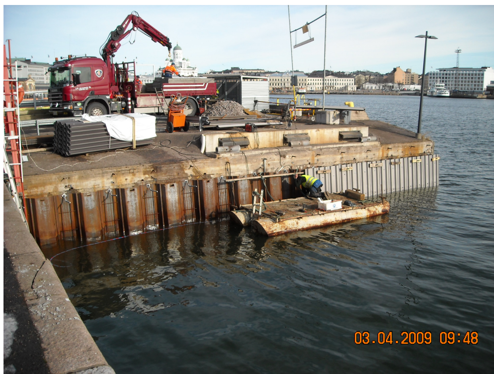
Kuva 31 Muovipontin asennusta (Helsingin satama 2012.)
