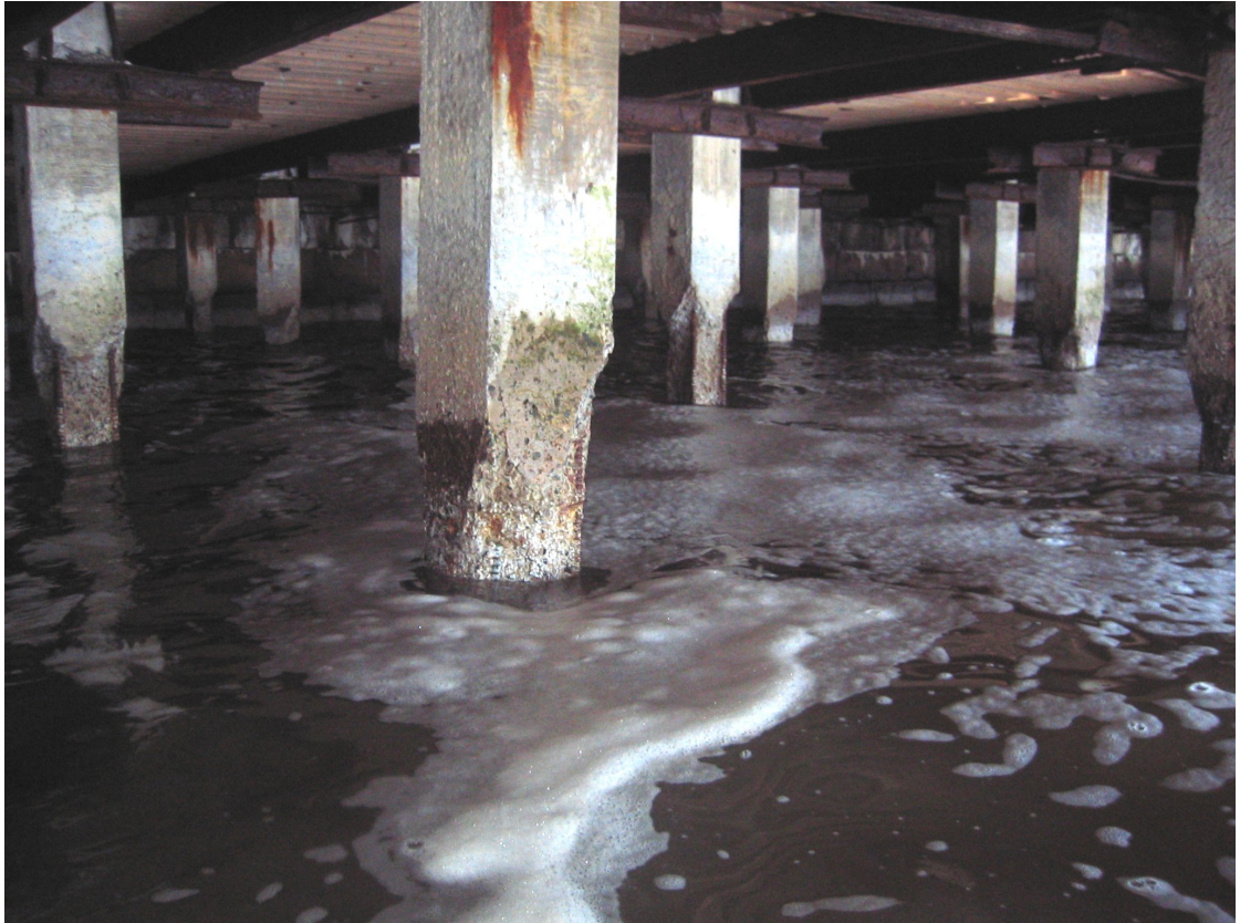
Kuva 35 Jäiden vesirajasta vaurioittamia paaluja (Helsingin satama 2012.)
