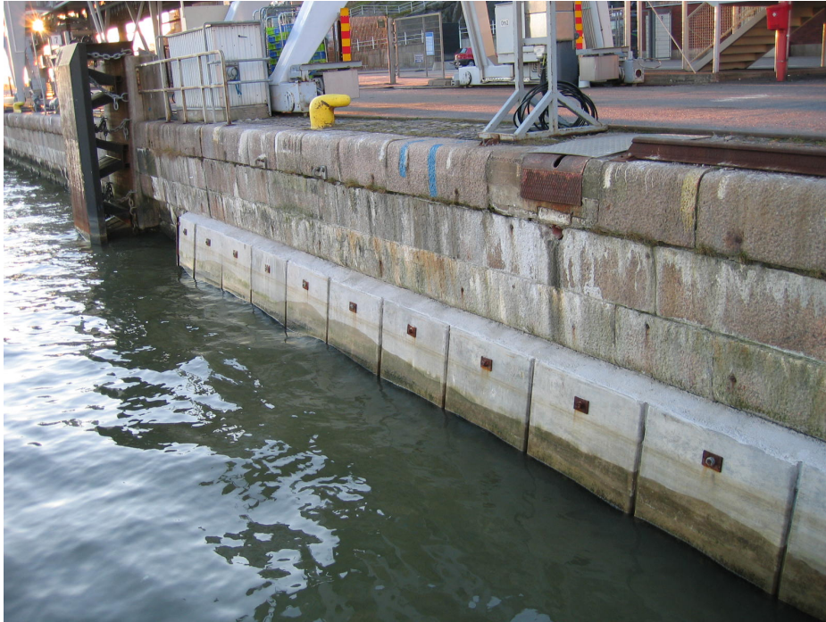
Kuva 34 Valmis teräsbetoniponttaus (Helsingin satama 2012.)
