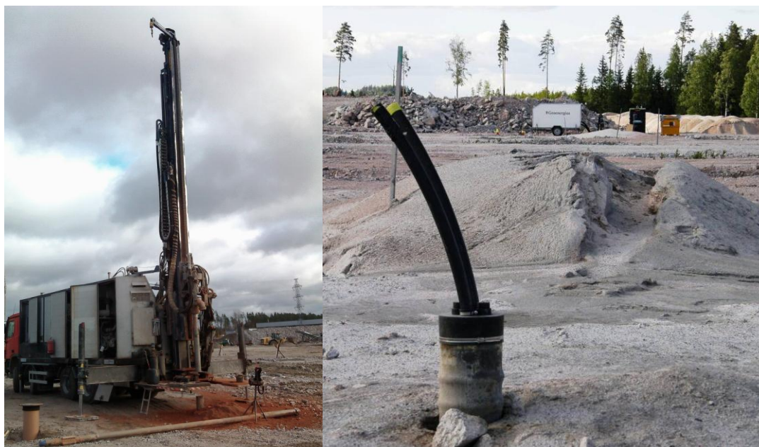
Kuva 13 ja kuva 14. Porauskalustoa (vas.) ja tutkimuskaivo, takana poraussoijaa ja taustalla TRT-vaunu (oik.) (20.)
