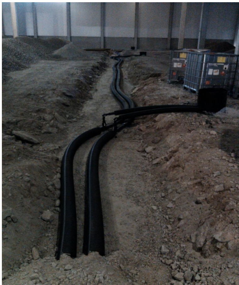
Kuva 16. Maalämpöputkien avoimet kaivannot kaivojen välillä (20.)
