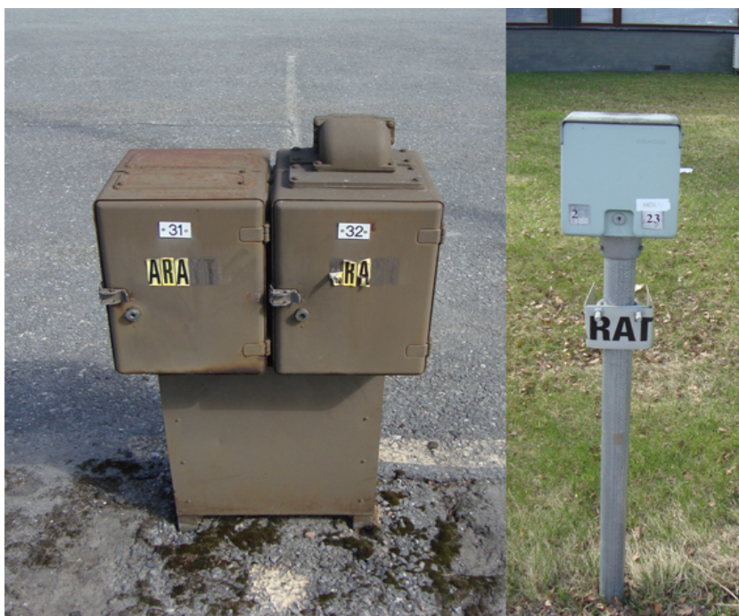
Kuva 8. Autolämmityspistorasioita.
