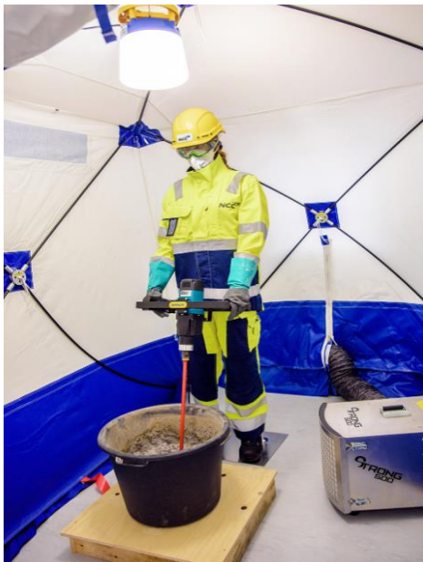
Kuva 7. Tasoteen valmistus osastoidussa tilassa (TTHA)
