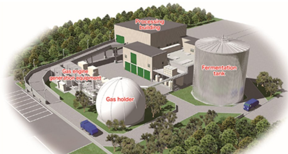
Kuva 3. Havainnekuva biokaasulaitoksesta. Kaasuhuppu tai kaasukello (kuvassa) on biokaasulaitokselle tunnusomainen rakenne. (Bioenergy International, 2017)
