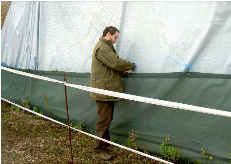
KUVA 7. Suojaverkon nostaminen paketin reunoille ja sen yhdistäminen ylimpään suojaverkkoon (Solař 2012).
