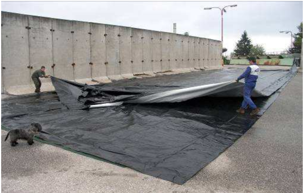
KUVA 3. Suojaverkon ja alusta folioiden levittäminen (Solař 2012).
