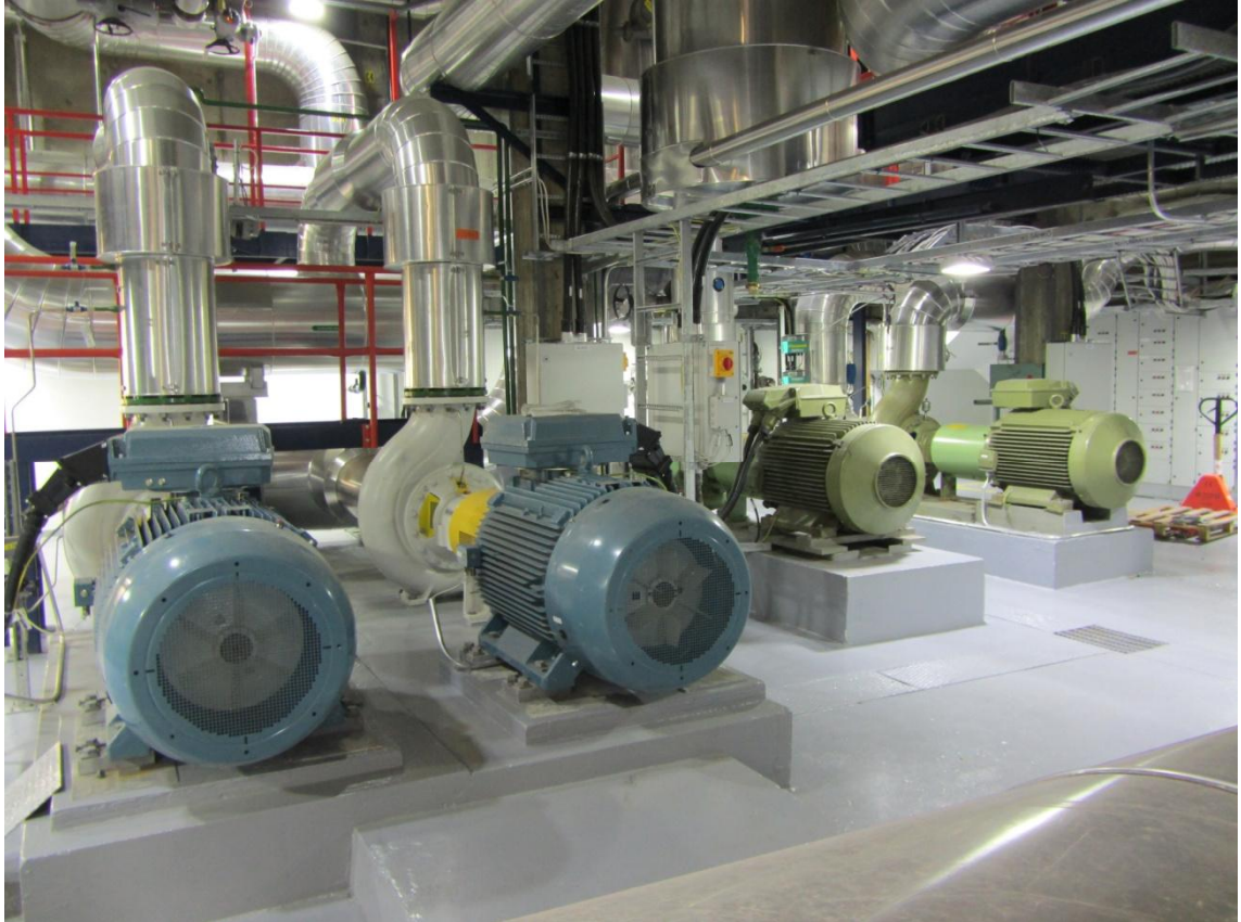
Kuva 13. Kaukolämpöpumppuja moottoreineen.
