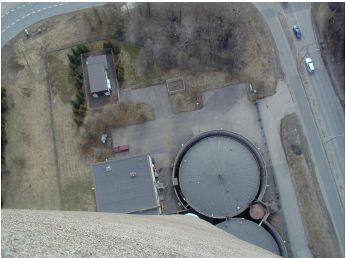
Kuva 17. Öljysäiliöt kuvattuna piipusta.
