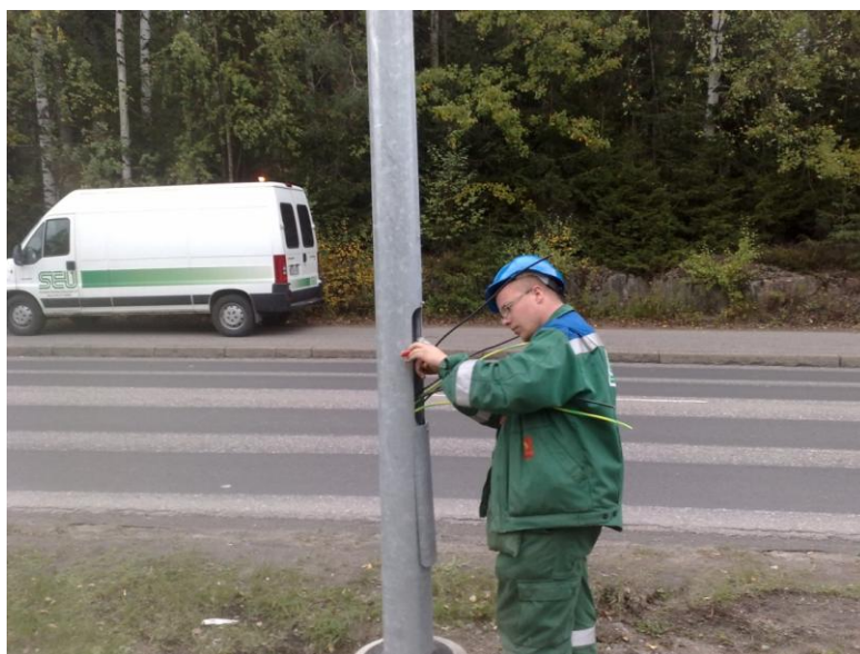
KUVA 7. Asentaja kytkemässä kaapeleita valaistuspylvään kytkentäluukulla
