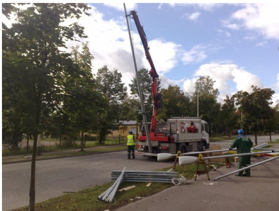
KUVA 9. Pylväs on valmiina kuljetettavaksi jalustalle
