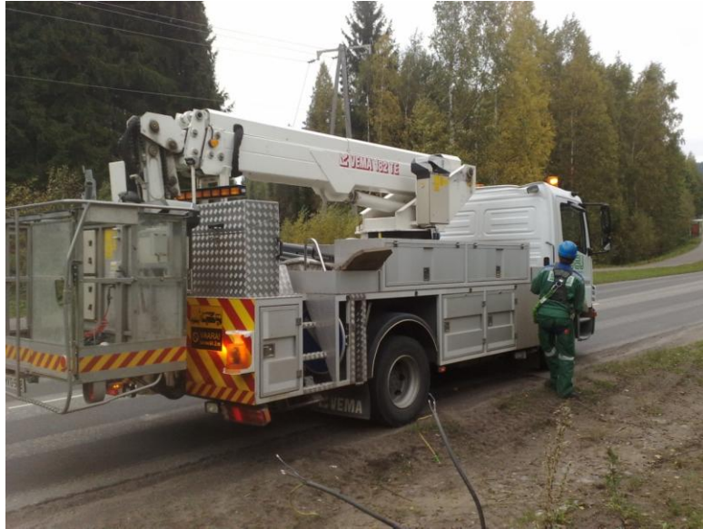
KUVA 6. Nostolava- autoa käytetään mm. valaisinten asennuksessa
