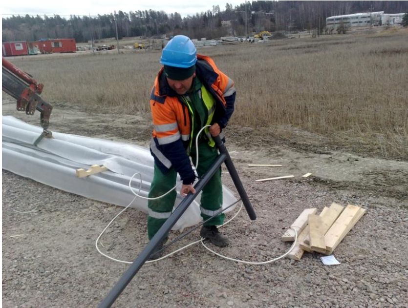
Kuva 18. Johto on vedetty valaisinvarteeseen, ja kuvassa vielä viimeistellään johdon riittävyys valaisimen kytkentään
