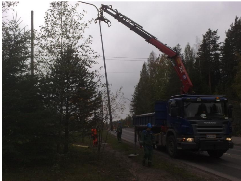
KUVA 5. Urakoitsija nostaa pylvään varsineen jalustaansa
