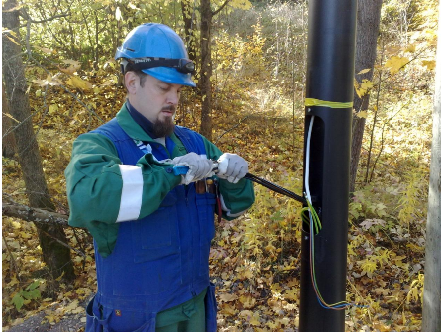
KUVA 15. Asentaja kuorimassa maakaapelia; kaapelipäätteitä ei tehdä
