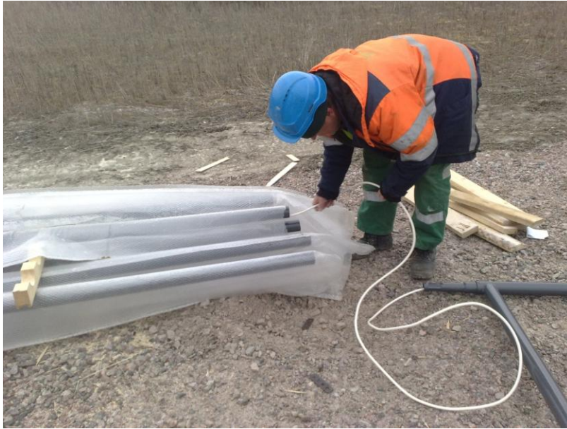
KUVA 20. Valaisinjohton loppuosa työnnettiin pylvääseen valaisimen kytkennän jälkeen
