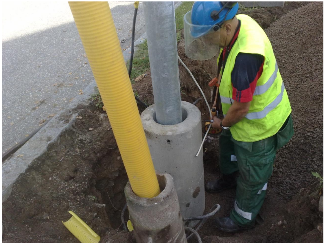
KUVA 11. Jalustan ruuveilla pylväs kiristetään tukevasti jalustaan kiinni
