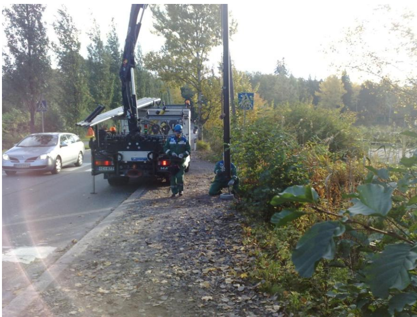
KUVA 14. Pylvään nosto jalustaansa
