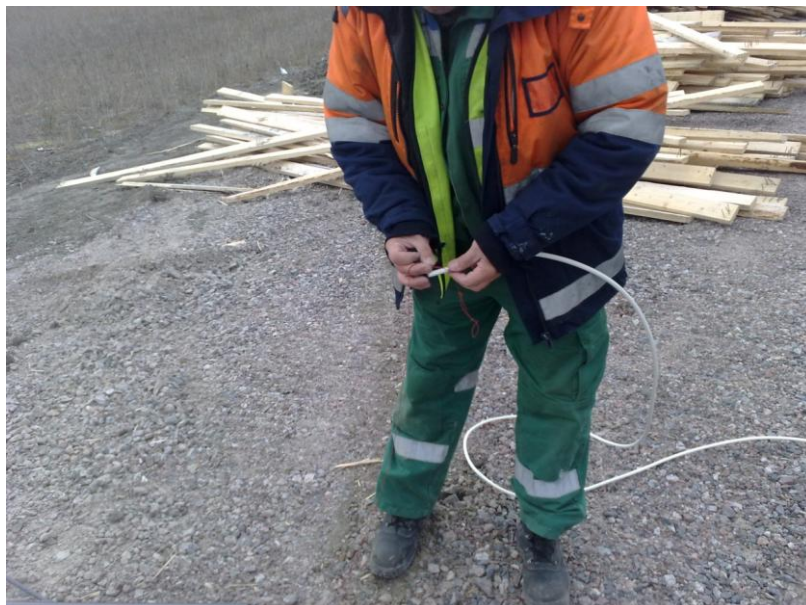
KUVA 17. Valaisinjohdon sidonta vetonarun ”painottomaan” päähän
