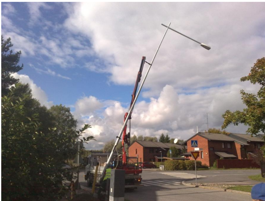
KUVA 10. Pylvästä nostetaan jalustaansa
