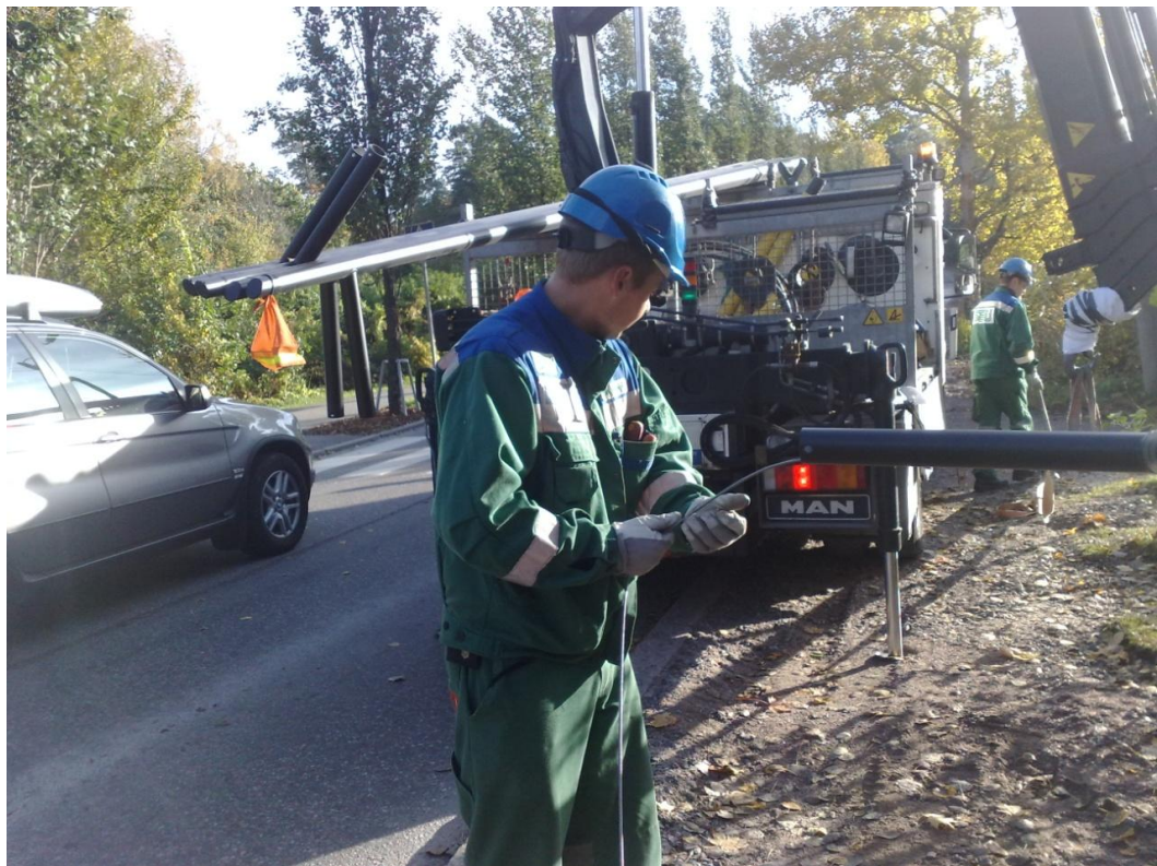
KUVA 12. Pylvään johdottaminen vetovaijeria apuna käyttäen
