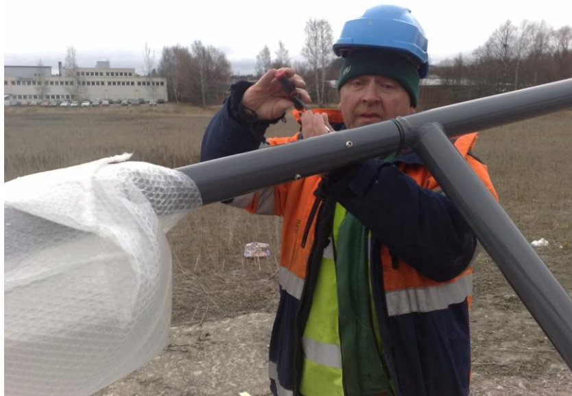
KUVA 21. Valaisinvarren kiristys pylvääseen. Pylvästä pidetään koholla nosturin avulla.
