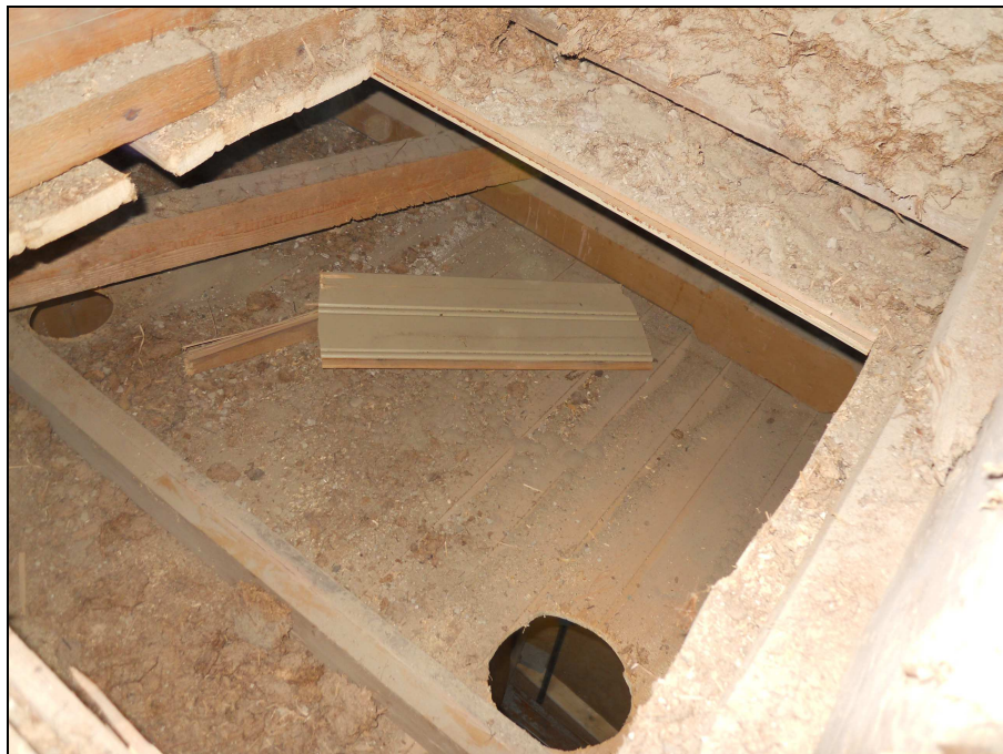
Kuva 27. Kattojen välinen tyhjä tila ullakolta katsottuna
