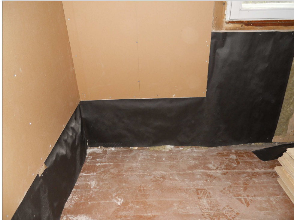
Kuva 12. Ulkoseinien tuulensuojapaperit
