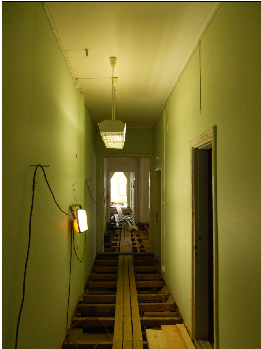
Kuva 20. Keskikäytävä, johon kanavat sijoitettiin
