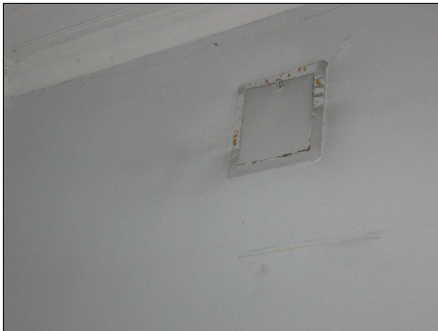
Kuva 5. Huoneen tuloilmaräppänä
