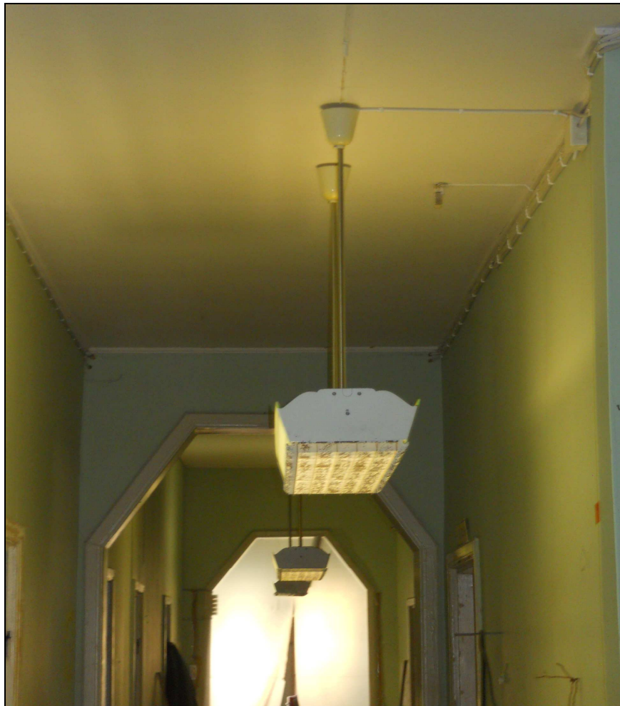
Kuva 24. Käytävän holvikaaret, jotka piti säilyttää
