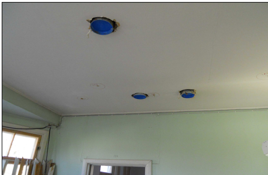
Kuva 19. Kanavien päitä huoneen katossa
