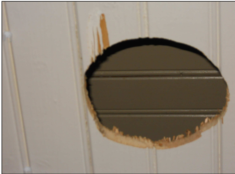
Kuva 26. Vanhaa kattoa huoneesta katsottuna
