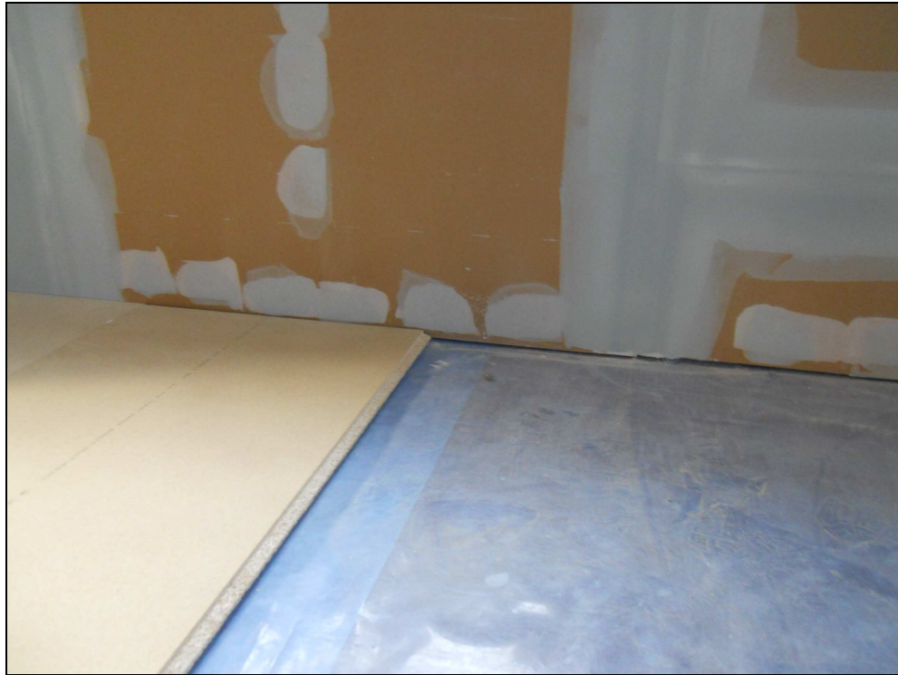
Kuva 13. Lattiaan asennettu muovi, joka on nostettu ylös ulkoseinän levyn alle
