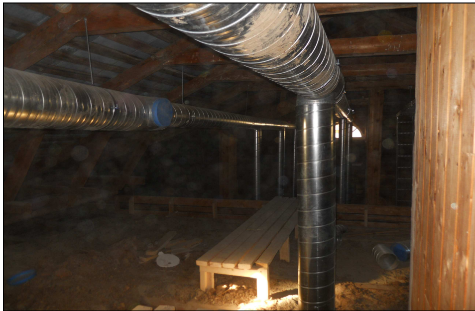
Kuva 17. Ullakolla olevia kanavia ja alas johtavia kanavia
