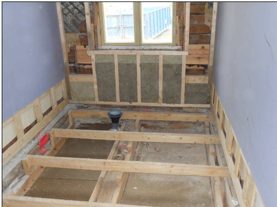
Kuva 11. Ulkoseinien koolausta, eristystä ja väliseinien levytyksiä
