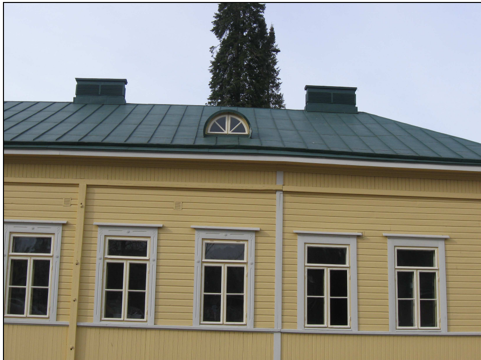
Kuva 10. Katolla sijaitsevat alkuperäiset iv- hormien piiput.
