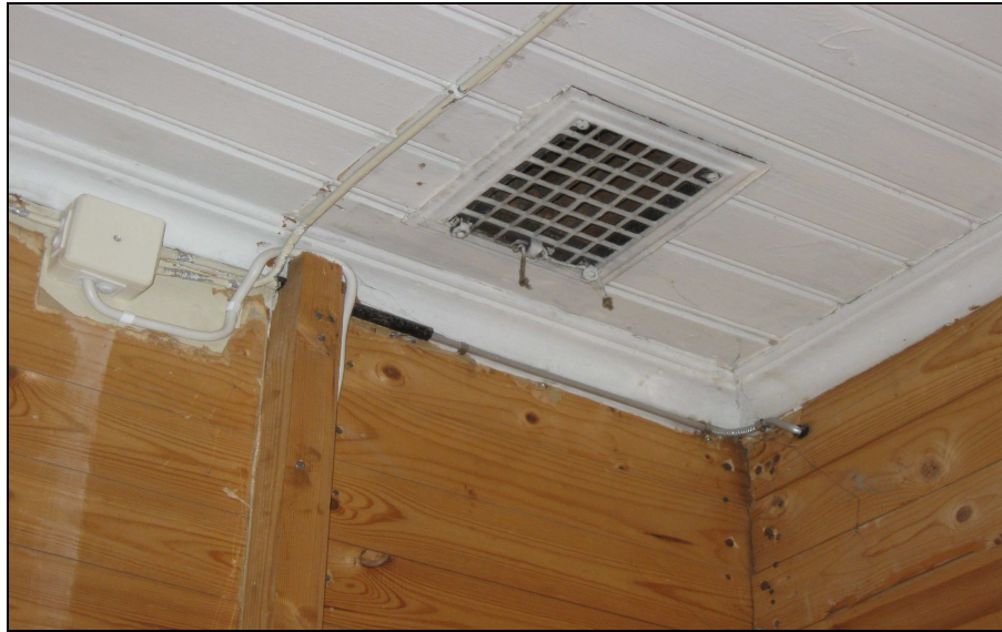
Kuva 4. Huoneen poistoilmasäleikkö
