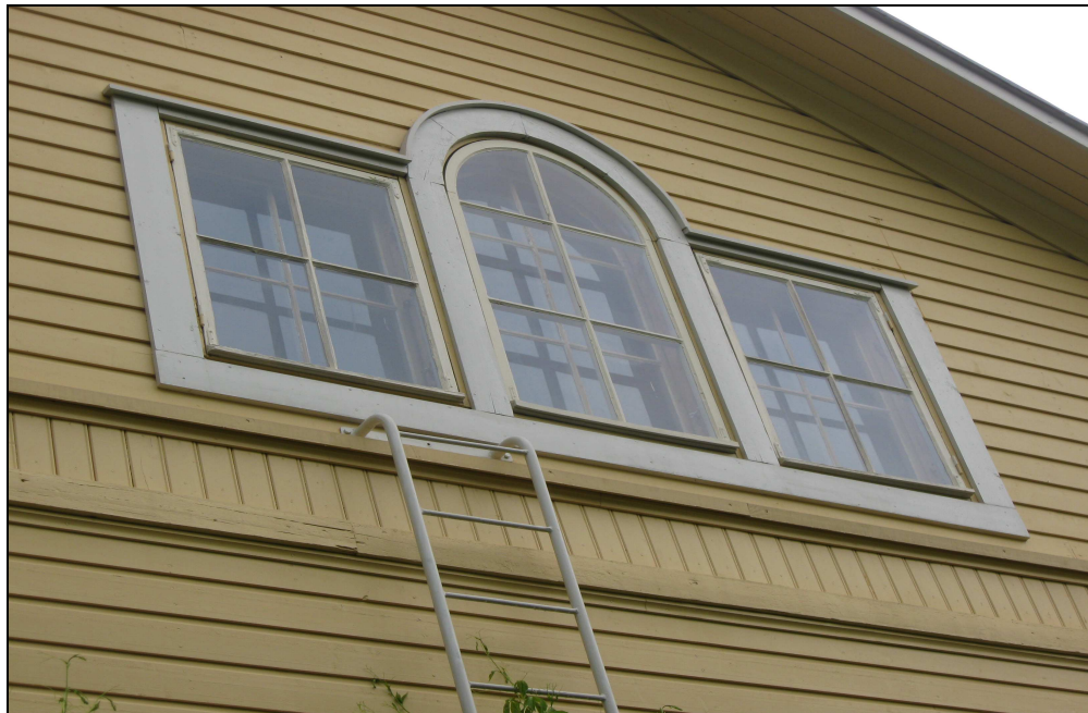
Kuva 6. Ullakon tulevan iv- konehuoneen ikkunat
