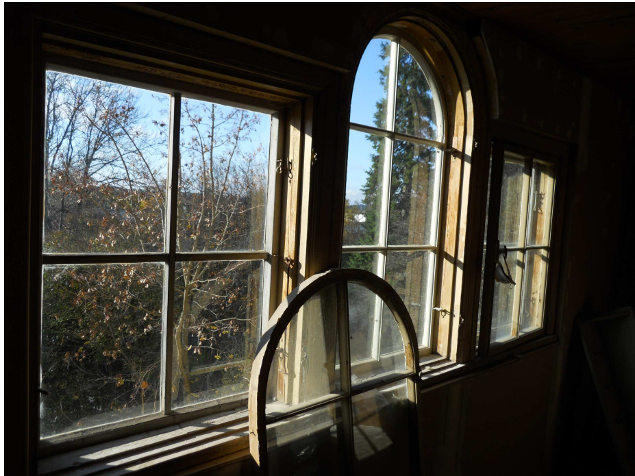
Kuva 15. Ikkunat, joiden tilalle sijoitetaan tuloilmasäleiköt
