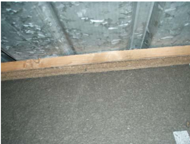
KUVA 14. Vinon katon osalta tuuletus puutteellinen (Tissari 2011)
