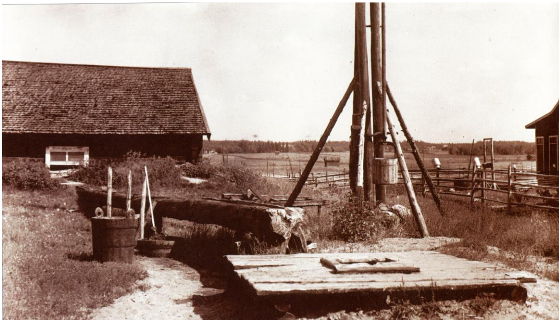
Kuva 1. Vinttikaivo ja navettaan johtava vesikouru Alahärmässä vuonna 1930 (Katko 1996, 111. Valokuva: S. Paulaharju / Museovirasto).
