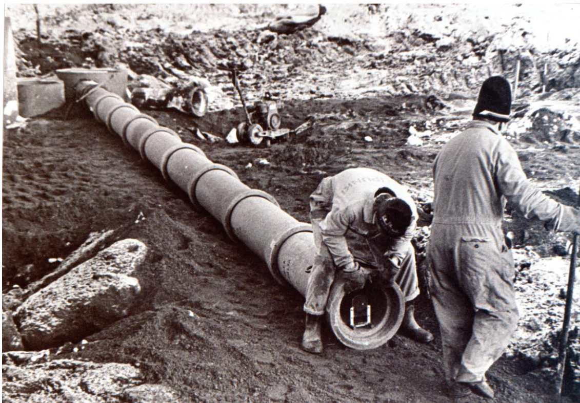
Kuva 4. Betonisen viemäriputken asennusta vuonna 1981 (Katko 1996, 225. Valokuva: LV Lahti Vesi Oy).
