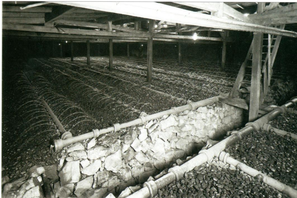
Kuva 2. Helsingin Alppilan jätevedenpuhdistamon sepelisuodatin (Katko 1996, 83. Valokuva: Foto Roos 3.11.1941 / Helsingin kaupunginmuseon kuvaarkisto).
