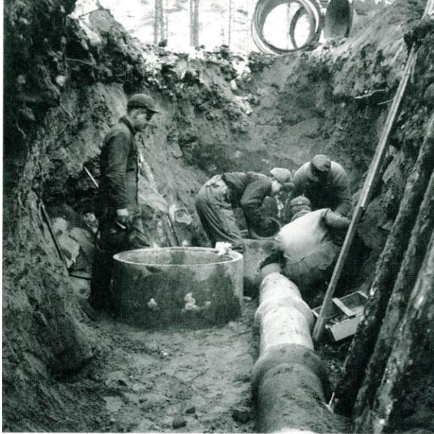
Kuva 5. Viemäriputken asennusta kunnantalon takana Riihikoskella vuonna 1972 (Holm 2003, 193. Valokuva: Yrjö Virtanen).
