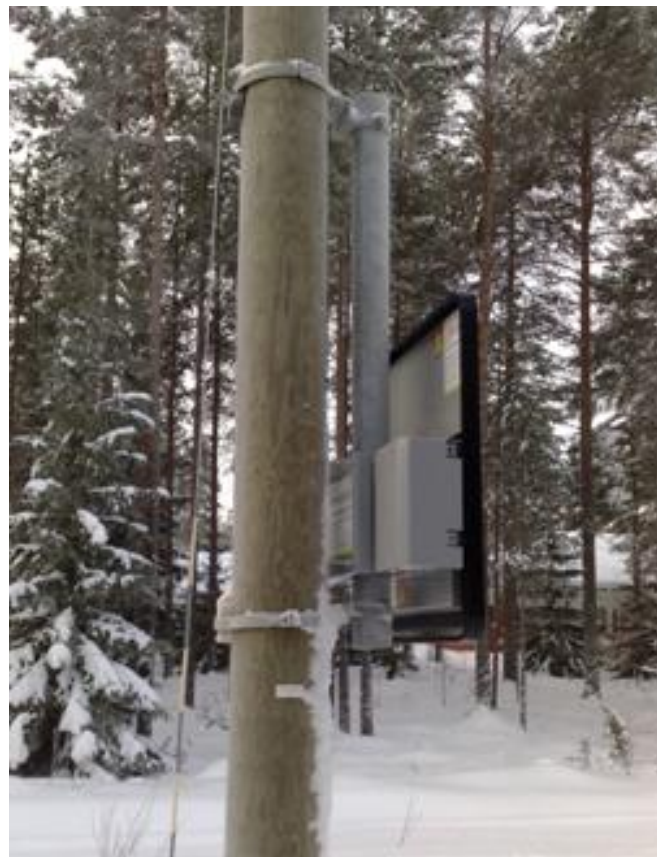
KUVA 31. Nopeusnäyttötäulu kiinnitettynä puiseen valaisinpylvääseen lisäkiinnikkeen avulla Haukiputaantiellä (tierekisteriosoite 848/3/3250)
