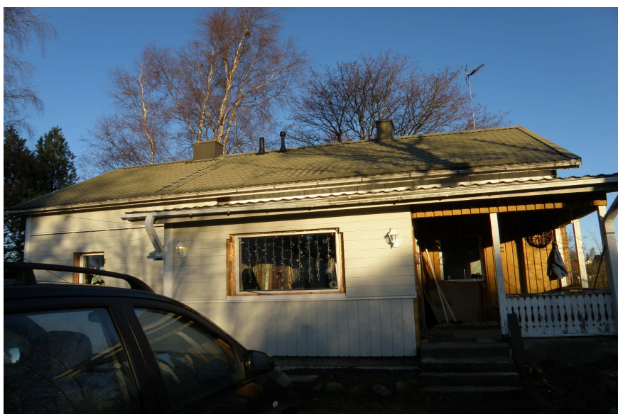
Kuva 2. Rakennus ulkoapäin nykyhetkellä.
