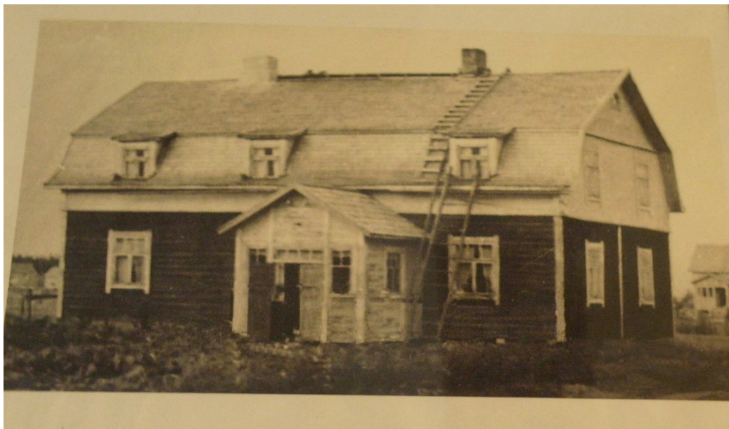
Kuva 1. Rakennus alkuperäisessä kunnossa ennen mitään muutostöitä.
