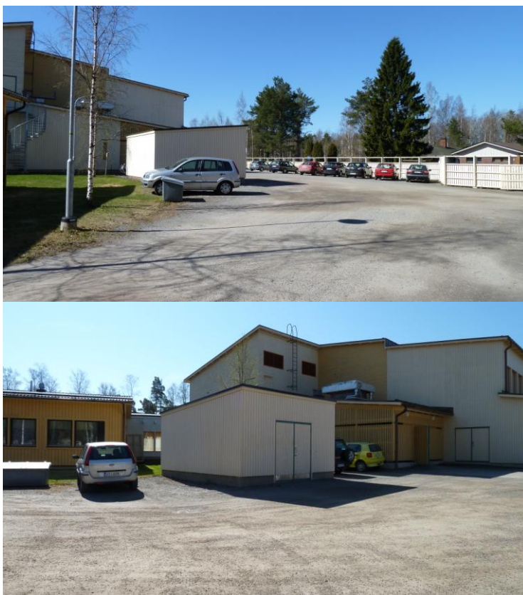
Kuva 11. ja Kuva 12. Gerby skolan jäteastiat.
