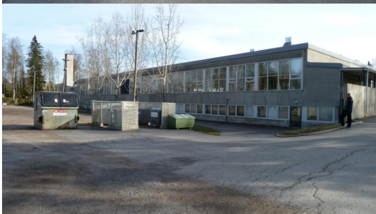
Kuva 20. ja Kuva 21. Hietalahden koulun jäteastiat.
