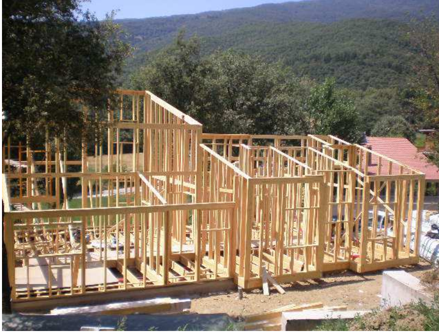
KUVA 3. Esimerkkitalo "Campins" Espanjassa runko pystytettynä
