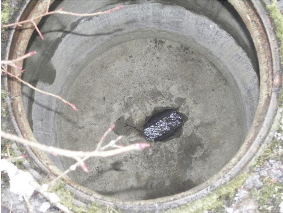
KUVA 19. Ehjä kaivo Maijalankorvessa. (Kuva: Jussi Tukeva 2012)
