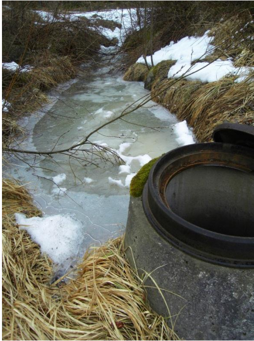
KUVA 9. Kaivo, johon ojavedet vuotavat. (Kuva: Jussi Tukeva 2012)
