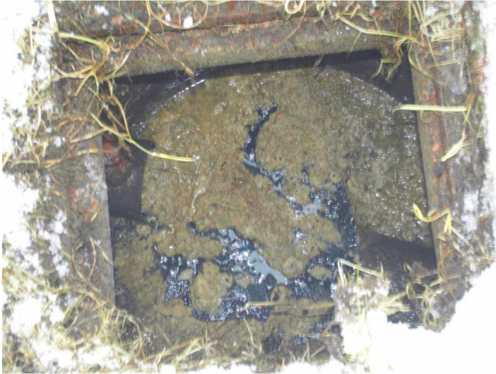
KUVA 20. Korjattava kaivo. (Kuva: Jussi Tukeva 2012)
