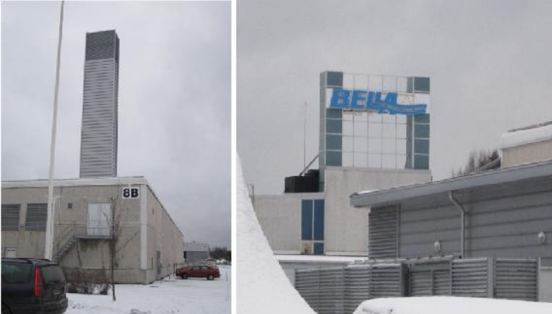
Kuva 8 Vasemmalla laitoksen 8B:n poistopiippu ja oikealla laitoksen 10 poistopiiput. Kuvat Sanna Hyvönen.
