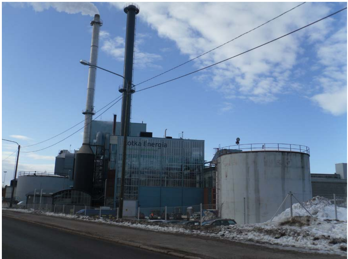
Kuva 2. Kotkan Energian Hovinsaaren voimalaitos. Kuvattu 13.3.2012
