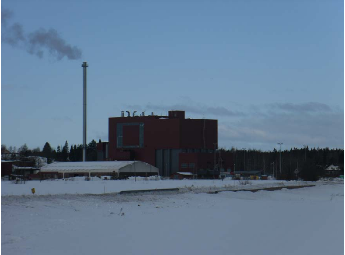
Kuva 1. Kotkan Energian Hyötyvoimala. Kuvattu 13.3.2012
