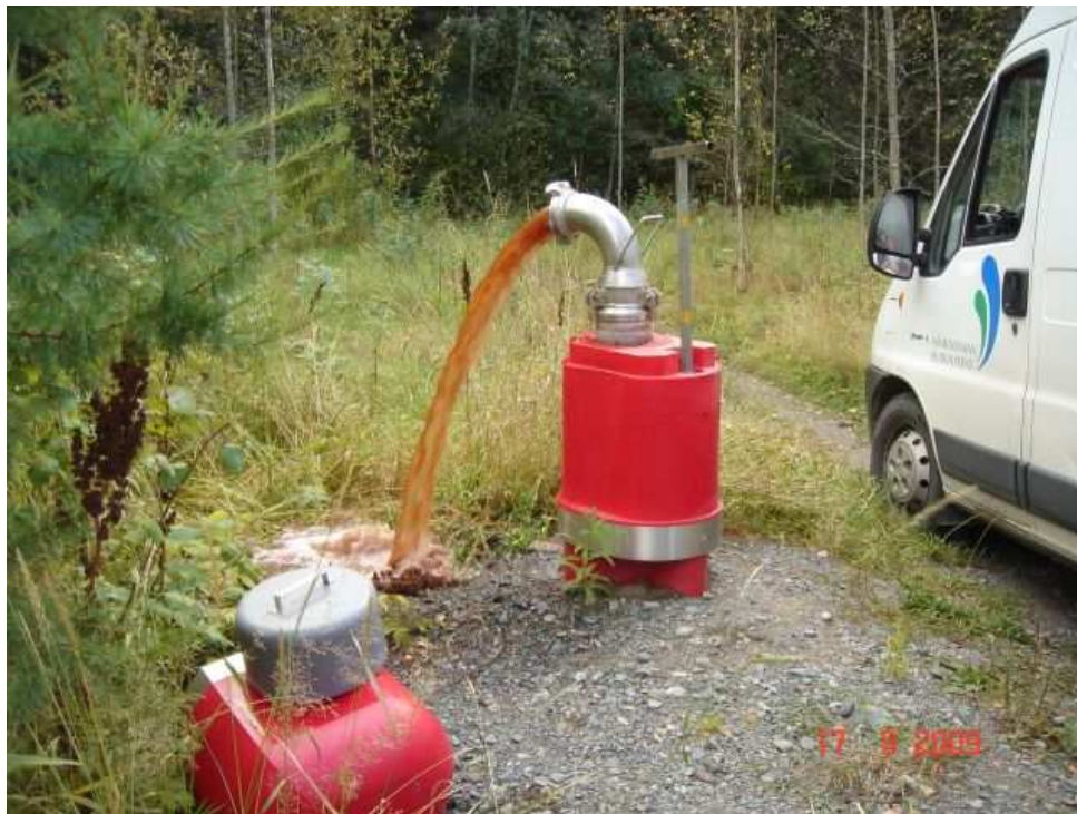
Kuva 7 Vesijohtoverkoston huuhtelua Hämeenlinnan Sammontiellä.
