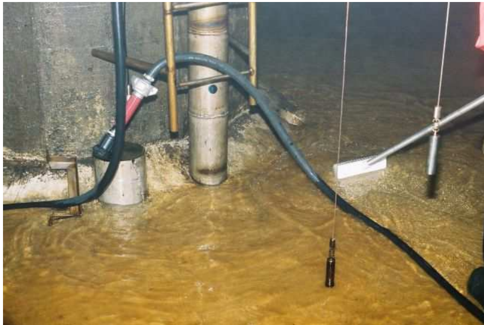
Kuva 1 Vesisäiliön pesua harjaamalla.
