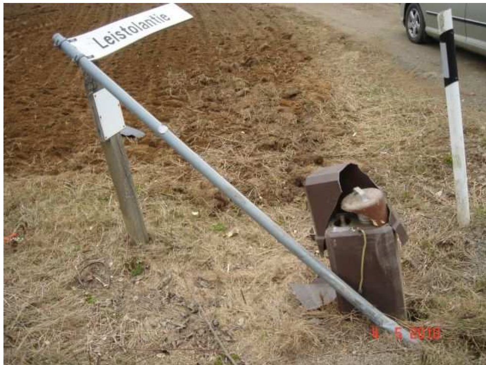
Kuva 13 Auton vaurioittama paloposti Hattulan Leistolantiellä.
