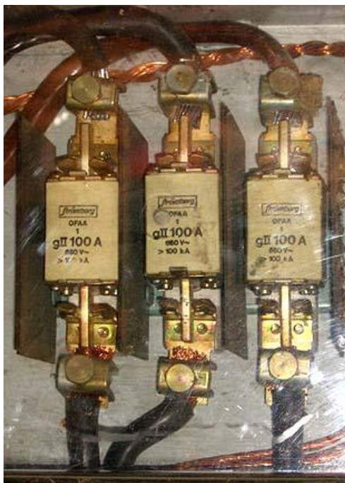
Kuva 16. Kahvavarokkeen muodostaa varokealusta ja kahvasulake /50/
