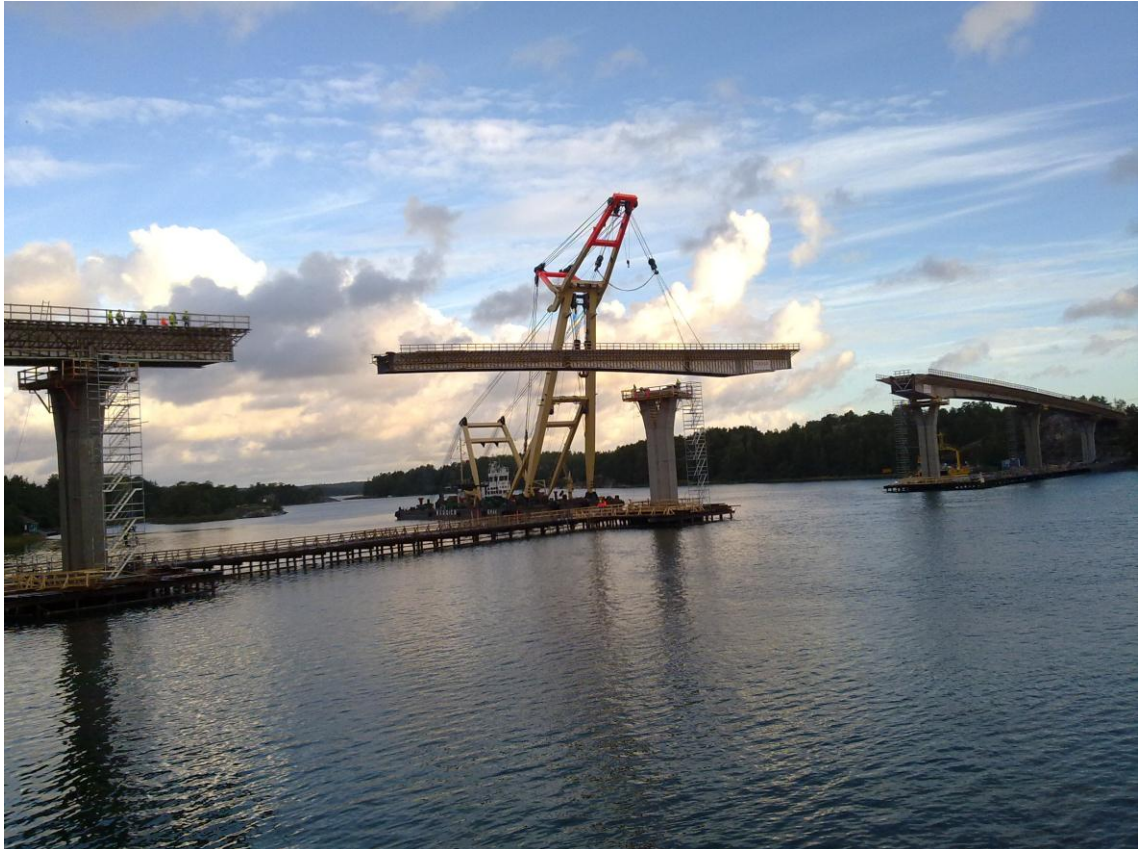
Kuva 2. Merinosturi Enak nostamassa siltalohkoa.
