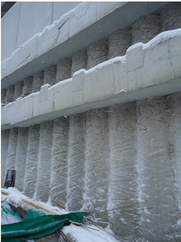
KUVA 3. Hiekkapuhallettua kaivinpaaluseinää Anttilan edustalla. Kuva Henri Laitinen 2012
