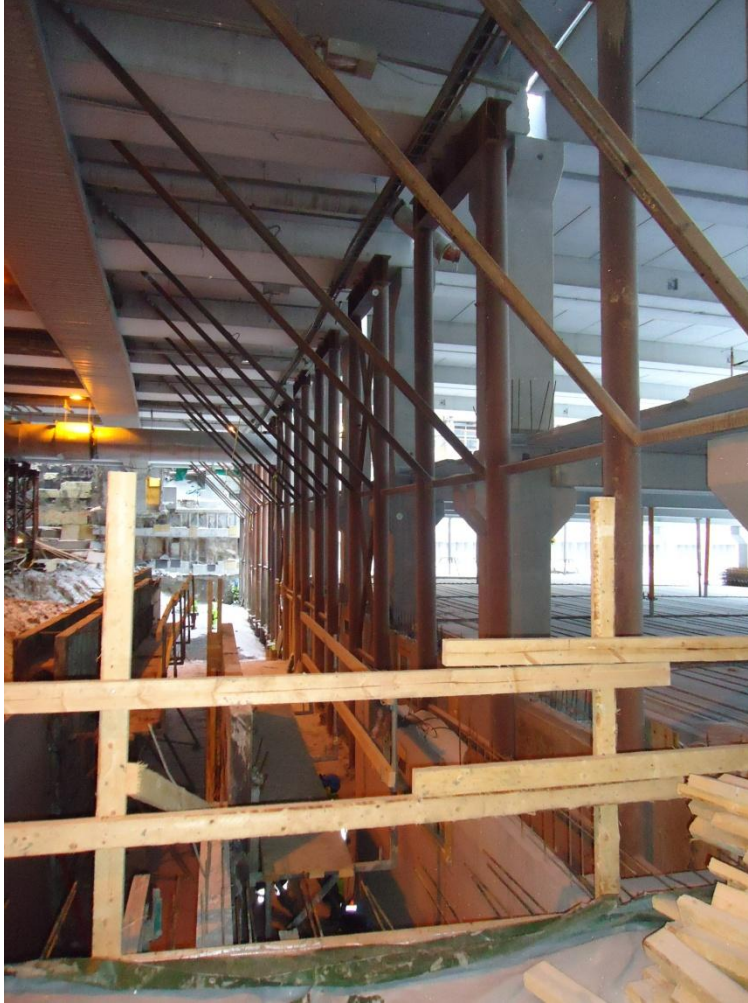
KUVA 8. Vanhan torikannen tuenta porapaaluilla. Kuva Henri Laitinen 2012.
