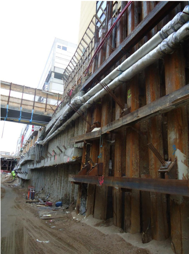
KUVA 7. Puijonkadun ajorampin ankkuroitua teräsponttiseinää.
