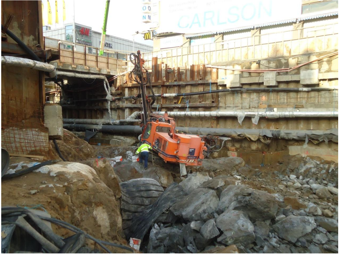
KUVA 15. Louhintatyöt käynnissä Alatorin työmaalla. Kuva Henri Laitinen 2011
