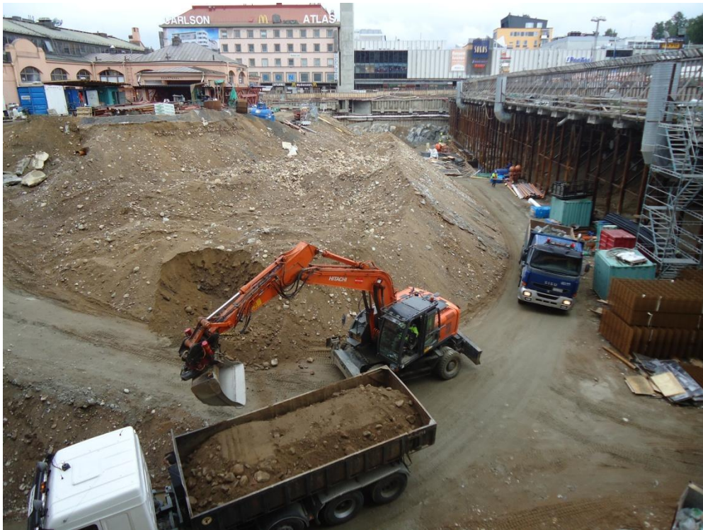
KUVA 10. Maankaivu käynnissä Alatorilla. Kuva Henri Laitinen 2011
