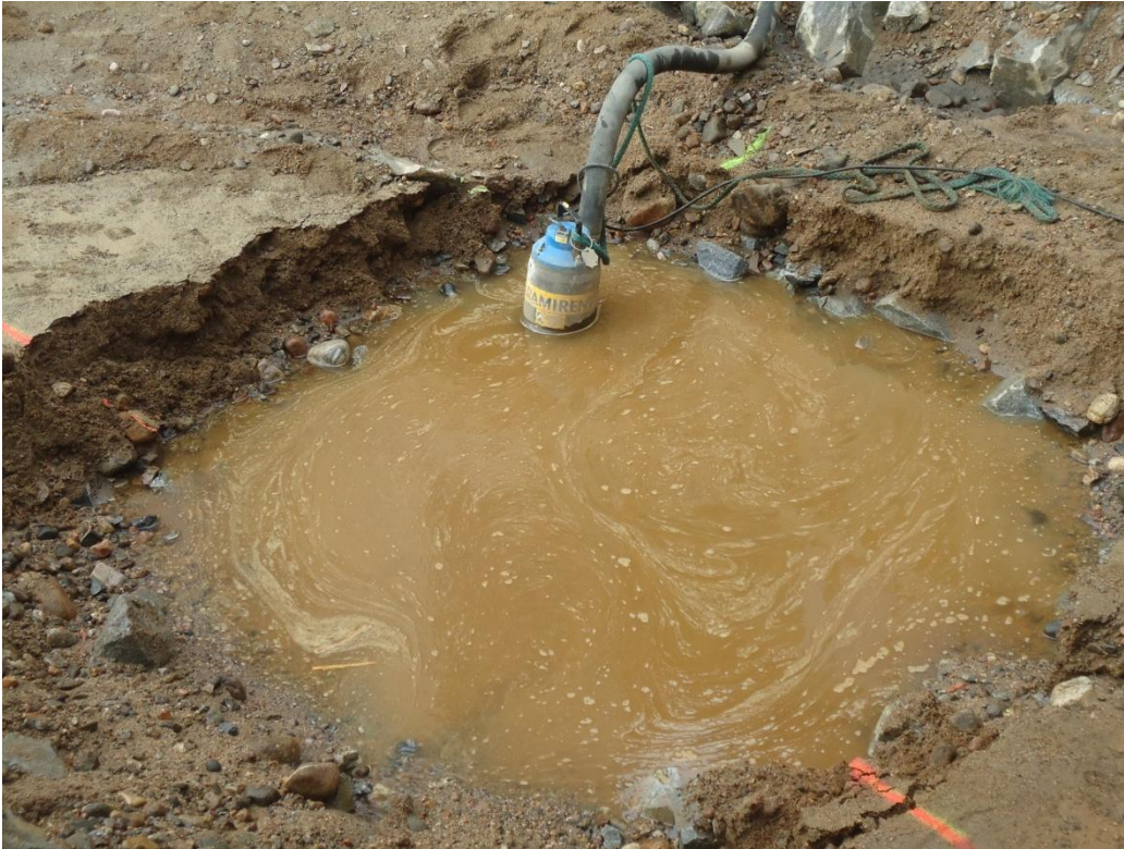
KUVA 11. Uppopumppu työssänsä torimontussa. Kuva Henri Laitinen 2011
