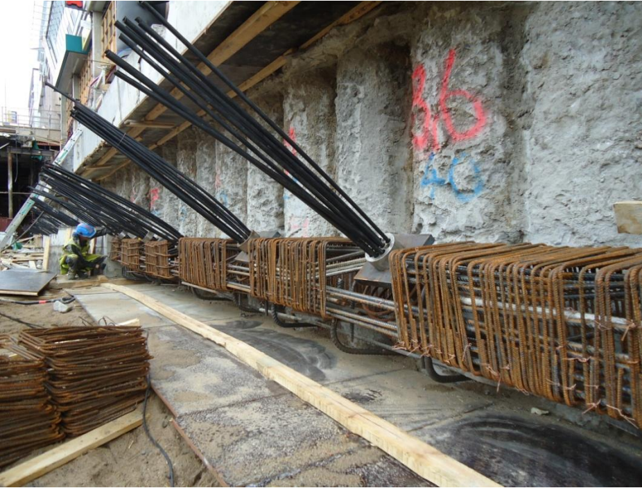
KUVA 1. Kaivinpaaluseinä sekä ankkuripalkin raudoitusta Alatorilla.
