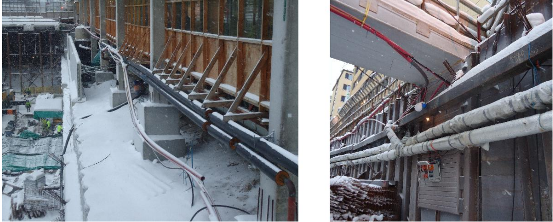
KUVA 14. Työnaikaisten putkien kannatusta Puijonkadulla. Kuva Henri Laitinen 2012
