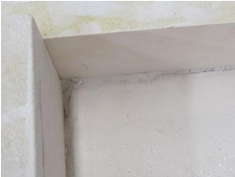
Kuva 15. Reunojen reiät peitetty kaoliinivillalla
