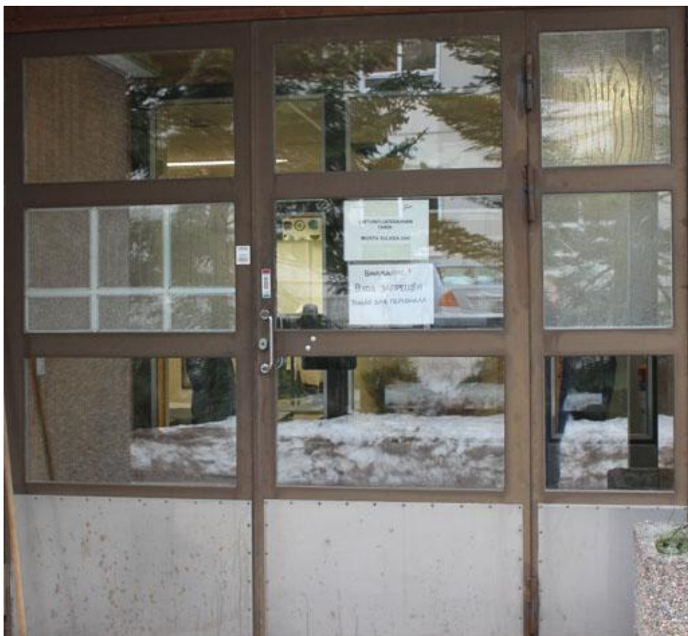
Kuva 33. Ovi ulkopäin. Lasilaatat paikoillaan ovesta. Iso kaura laatta uupuu vielä alimmasta ikkunasta.
