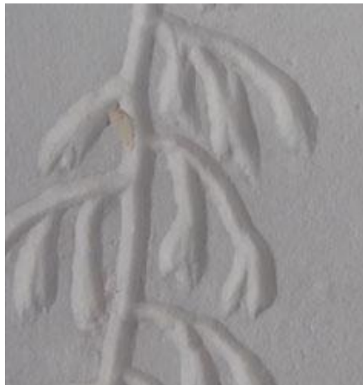
Kuva 20. Ei päästävä kohta kuviossa, muotista lähtenyt palanen pois.
