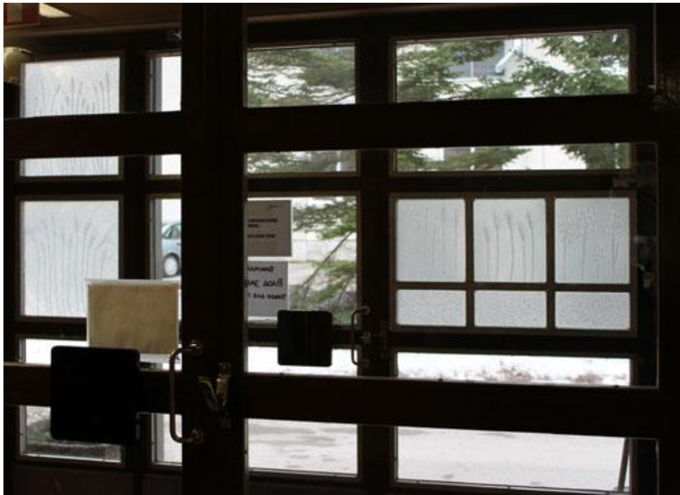
Kuva 32. Ovet kokonaisuudessaan sisältäpäin. Lasilaatat paikoillaan ulko-ovessa.
