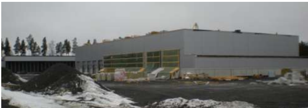
Kuvio 3. Uusi korjaamo rakennusvaiheessa
