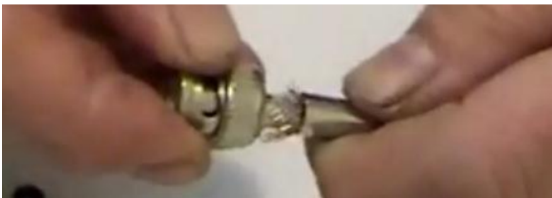
Kuva 27. Puristusholkin asettaminen liitinrungon kantaan [23].
