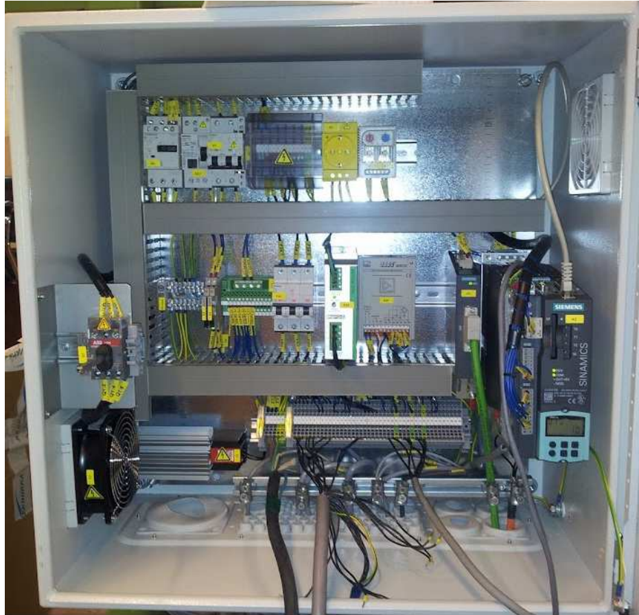
KUVA 14. BCA –sähköohjauskaappi.
