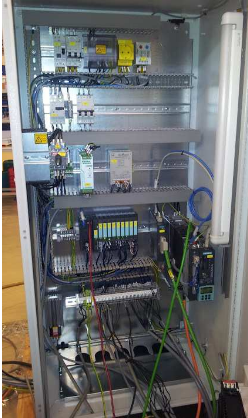
KUVA 12. CCA –sähköohjauskaappi.
