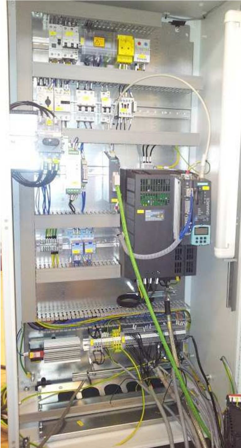
KUVA 10. SWC –sähköohjauskaappi.
