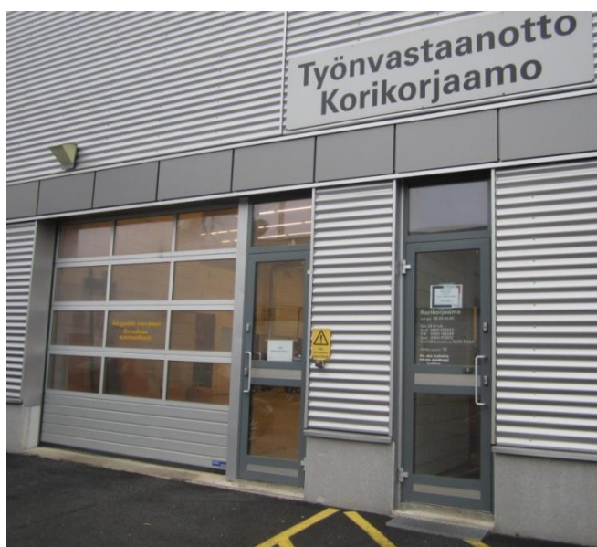
KUVA 4. Korikorjaamon työnvastaanoton sisäänkäynti (Kuva: Vesa Vuohoniemi 2012, muokattu)
