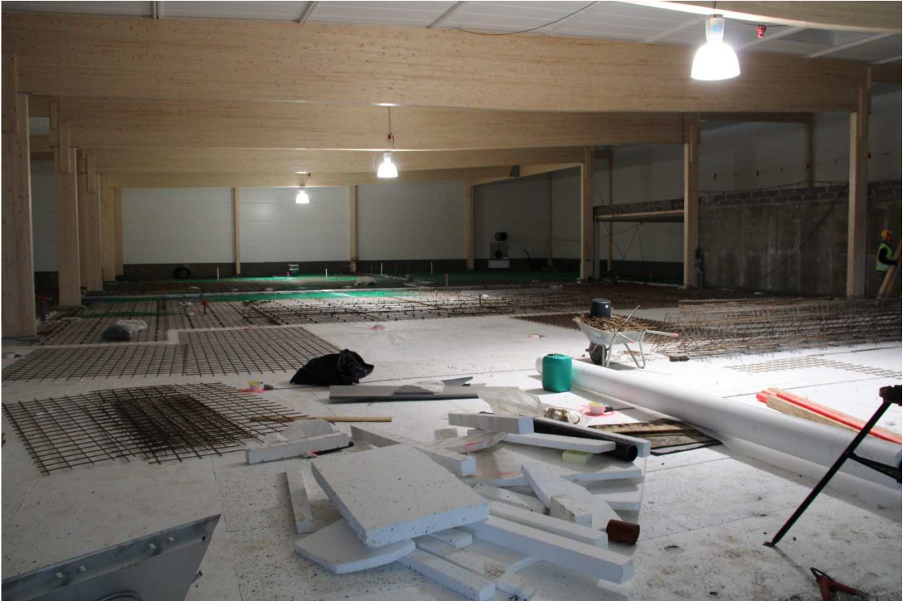
Kuva 3: Lattian eristys ja raudoitus. (Valokuva Markku Piik).
