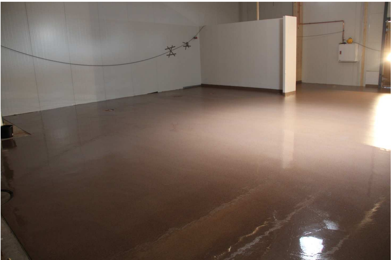
Kuva 6: Akryylinpinnoite. (Valokuva Markku Piik).
