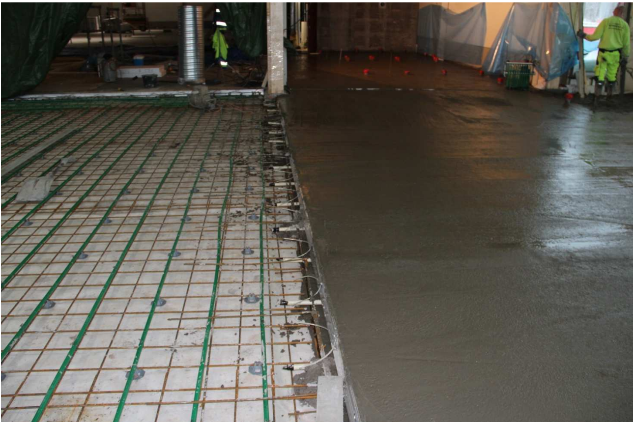
Kuva 4: Lattiavalu. (Valokuva Markku Piik).
