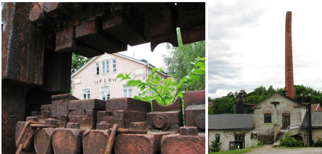
Kuvat 12 ja 13. Billnäsin ruukin rakennuksia (Toivio 2009)
