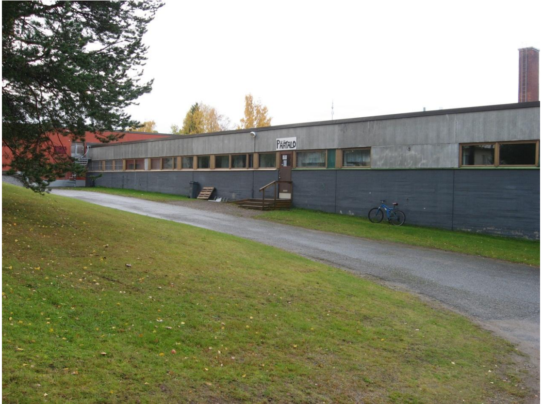
KUVA 1. Entisen lukion harmaata julkisivua ja tiiliverhoiltu kirjasto. Kuva Mikko Vepsäläinen.
