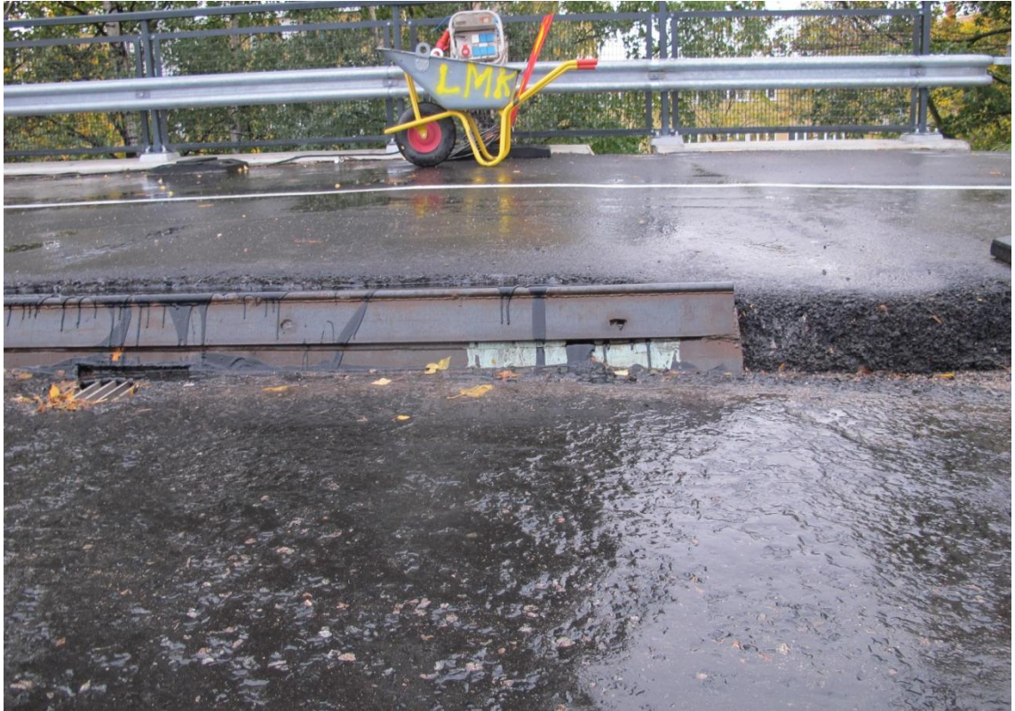
Kuvio 12. Ajoradan ja jalkakäytävän välisen reunateräksen korjaustyötä
