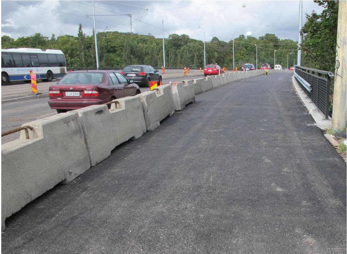
Kuvio 10. Liikenteen erottaminen työalueesta betoniporsasaidalla
