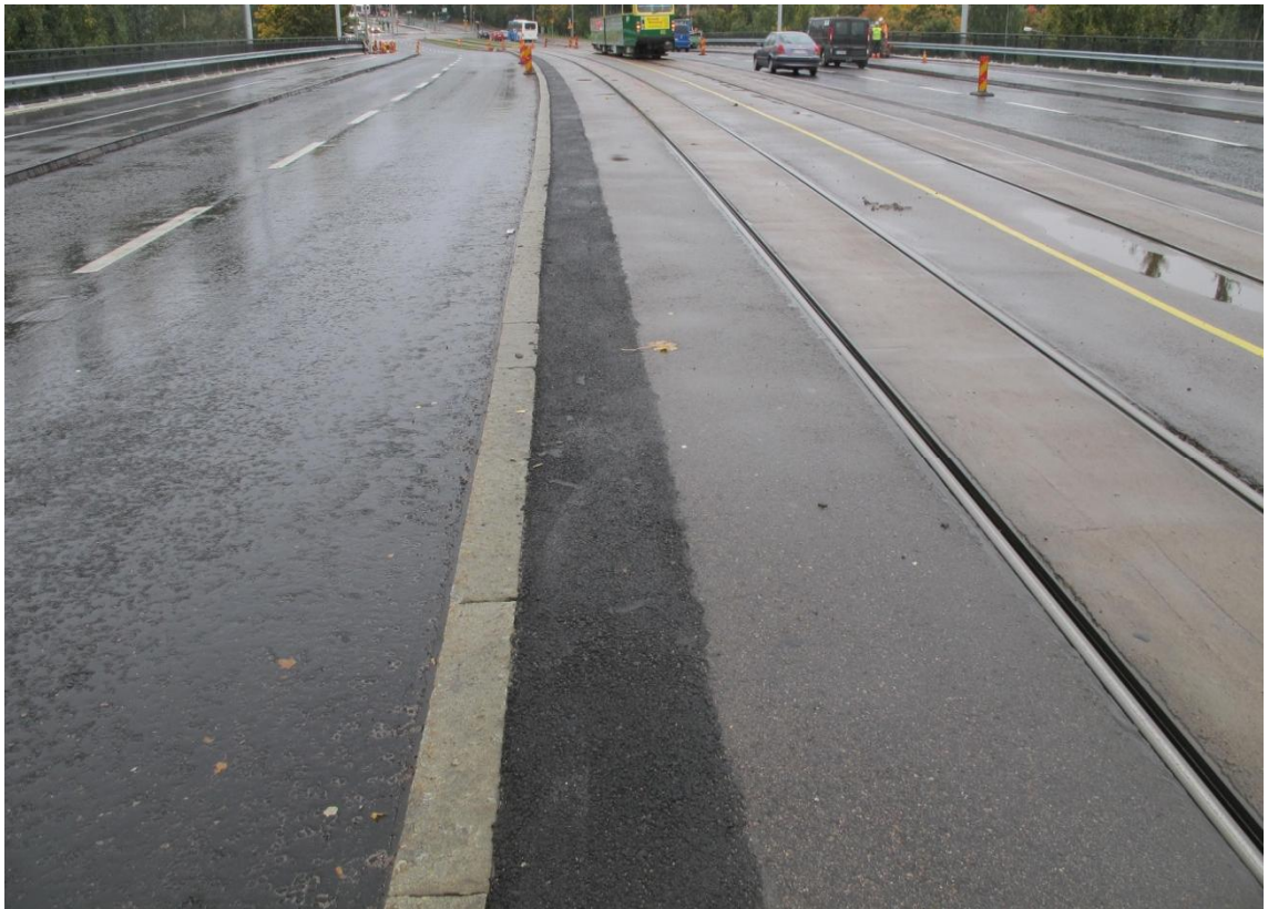
Kuvio 8. Uusittuja pintarakenteita
