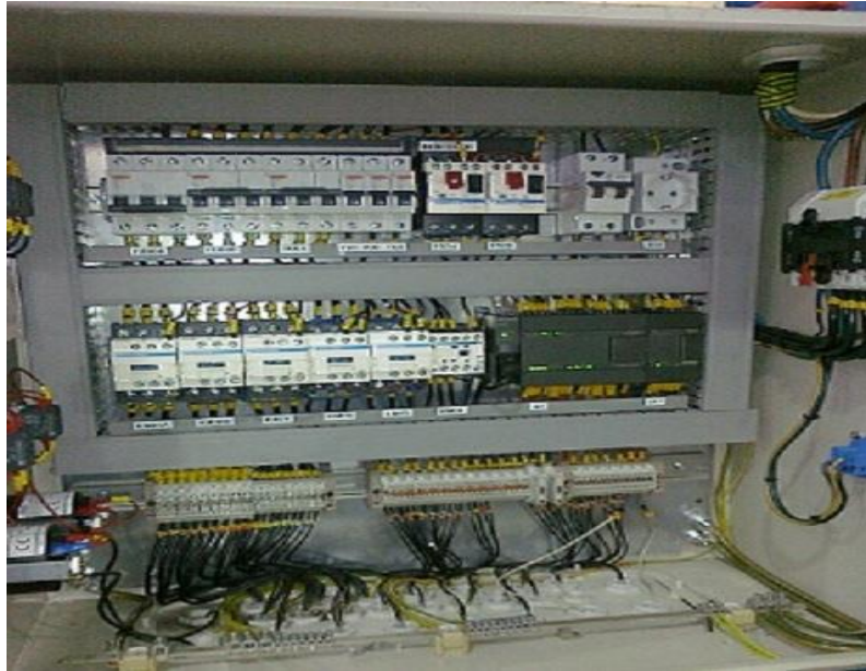
Kuva 4 Osienpesukoneen sähkötaulu
