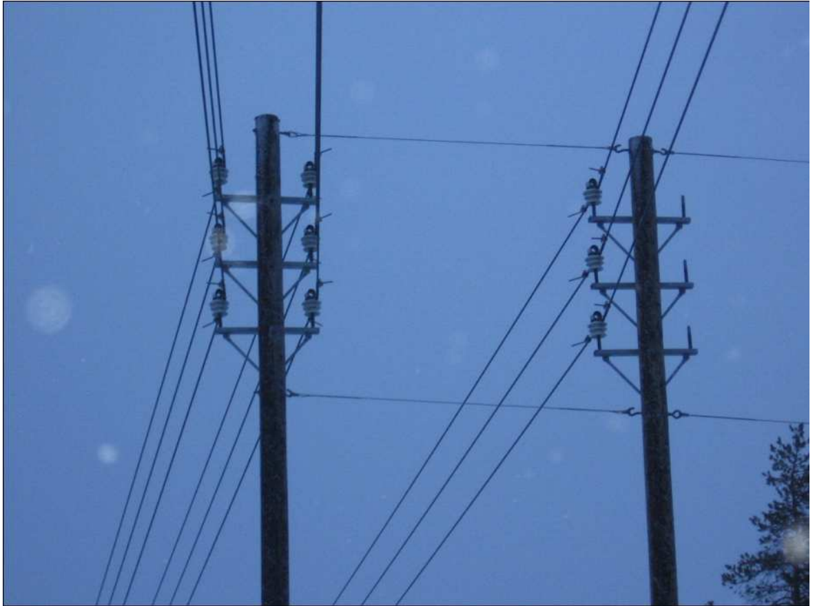
Kuva 9. Kaksoisjohtojärjestelmä päällystetyllä avojohdolla. /9/
