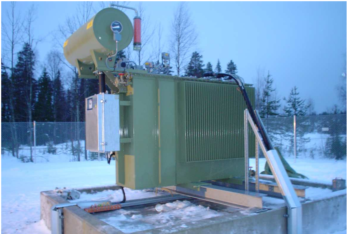
Kuva 5. Jännitteenkorotusmuuntaja /9/
