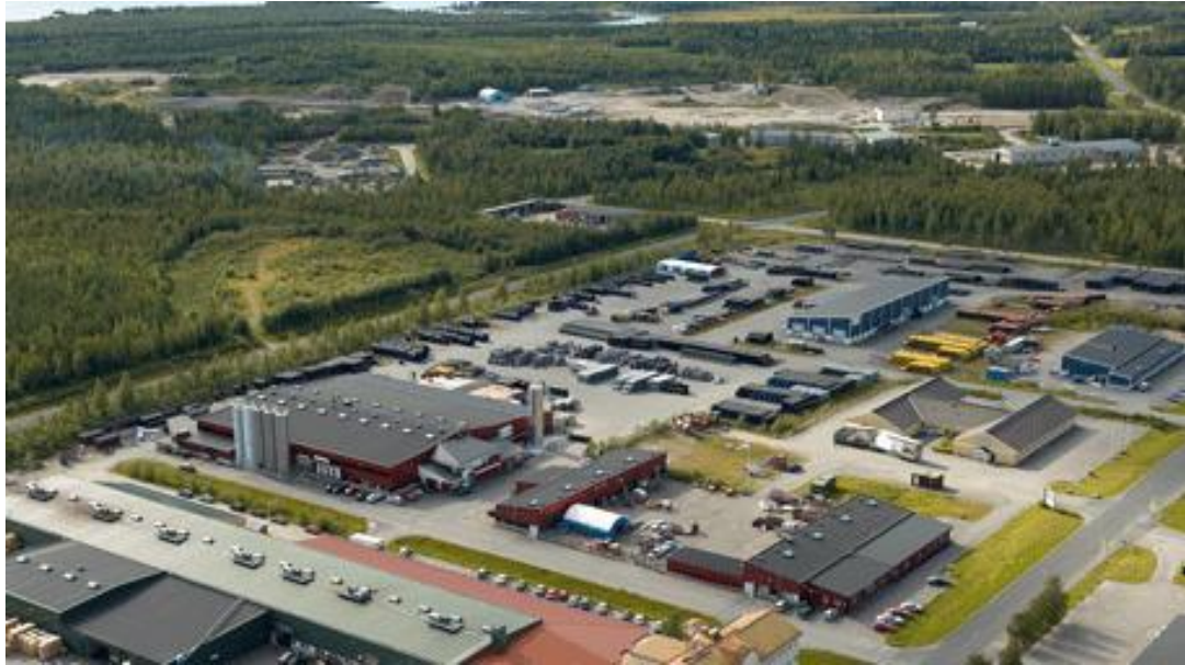
Kuva 8. Pipelife Hafab Ab Haaparannalla (Pipelife Hafab Ab – Haaparannan tuotantolaitos. 4.11.2011)
