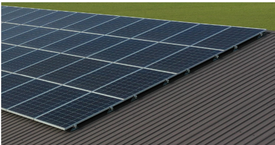
Kuva 19. Rakennuksen katon mukaisesti tehty asennus.
