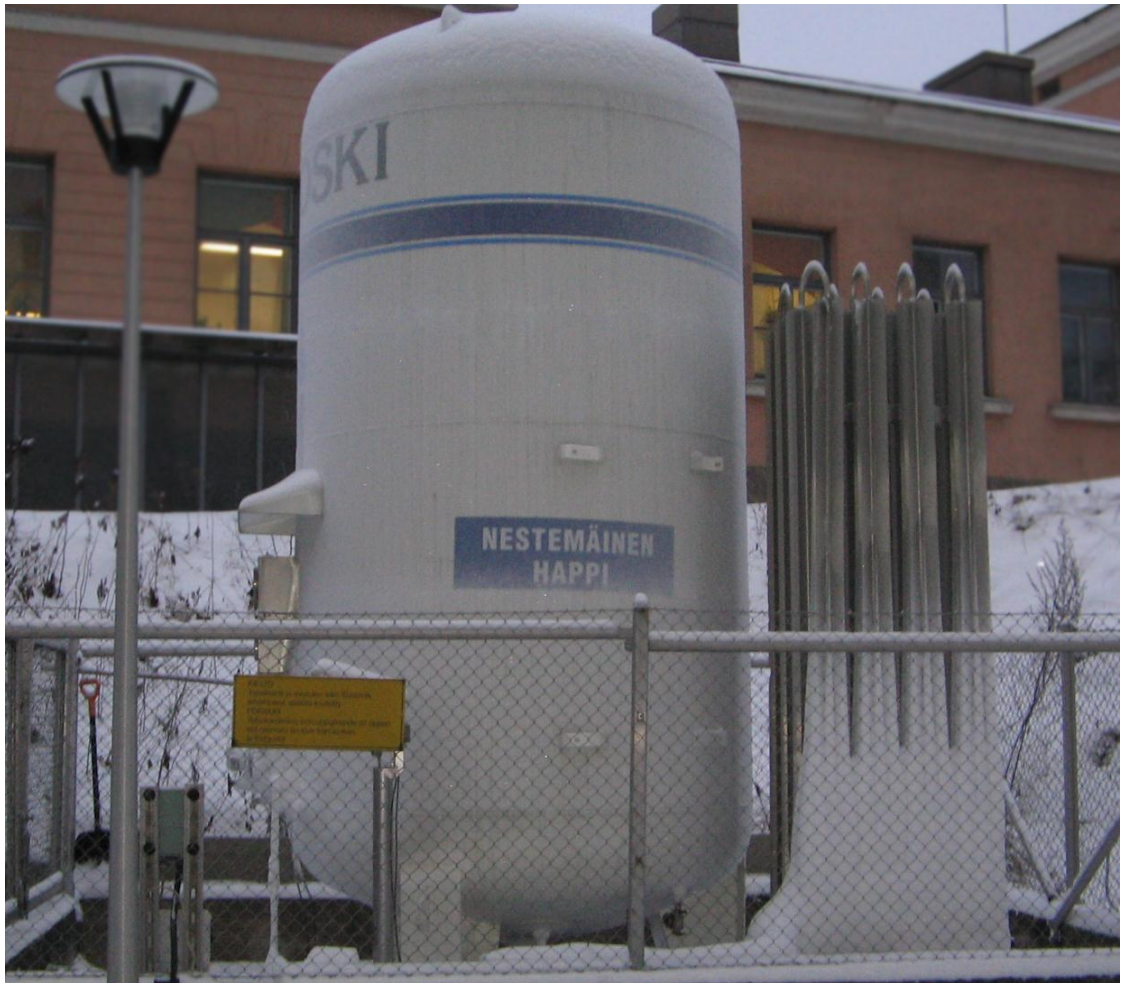
Kuva 3. Hapen varastosäiliö ja höyrystin
