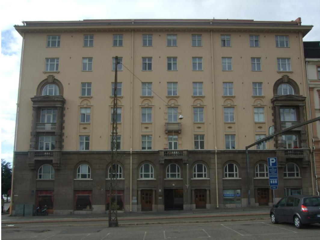
Kuva 16. As. Oy Hietalan toinen julkisivu.
