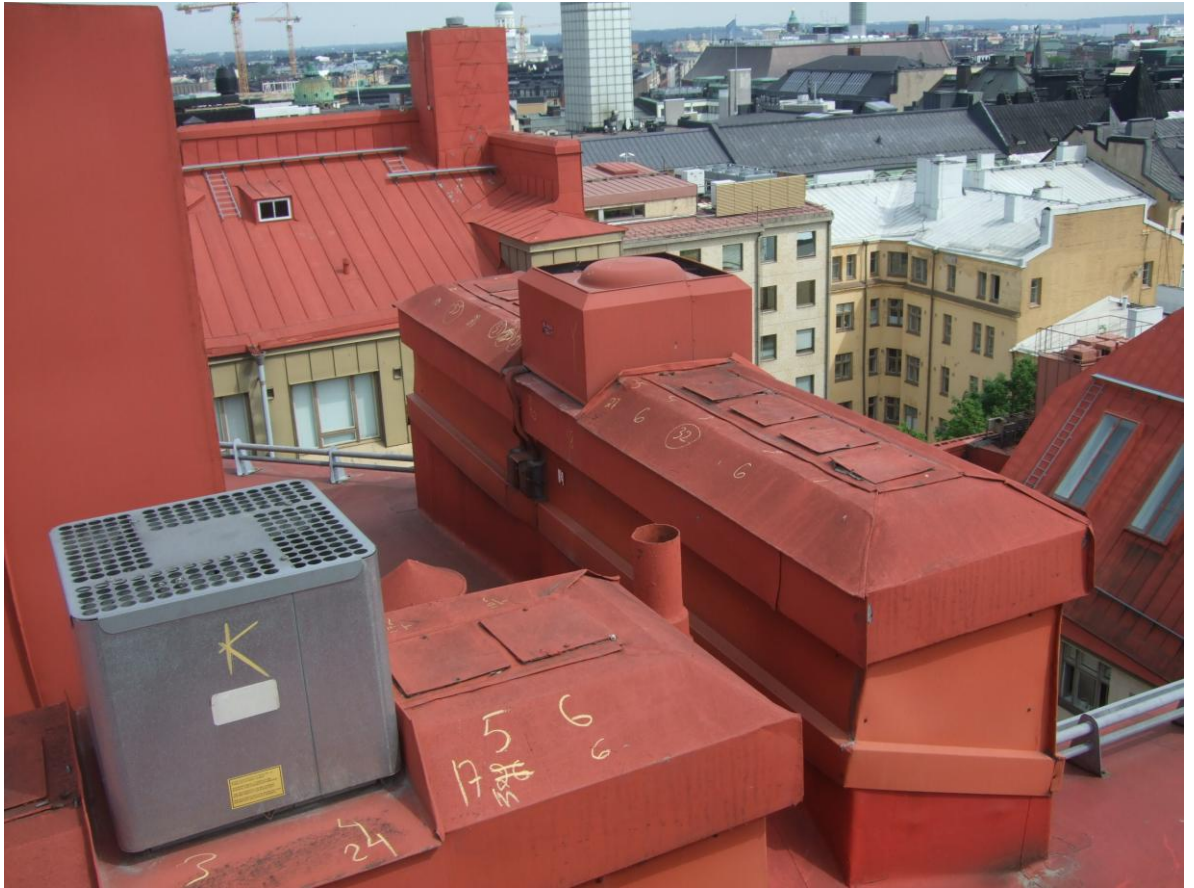
Kuva 14. Huippuimureita hormiryhmien päähän asennettuina. Hormiryhmän hormien suuaukot pellitetty kiinni.
